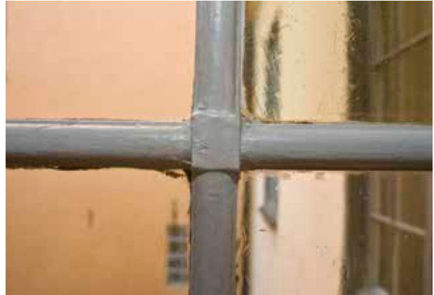
DETALJ AV FÖNSTER MED TÄRNINGSSPRÖJS I TRAPPHUSET. FOTO J. MALMBERG.
