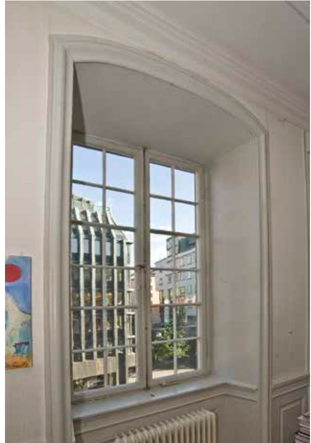
STICKBÅGIG FÖNSTERSMYG I LÄGENHET MOT GATAN. DET PROFILERADE FODRET ÄR AV EN TYP SOM VAR VANLIG PÅ 1700-TALET. DET SMÅSPRÖJSADE FÖNSTRET ÄR TILLVERKAT PÅ 1900-TALET. FOTO J. MALMBERG.
