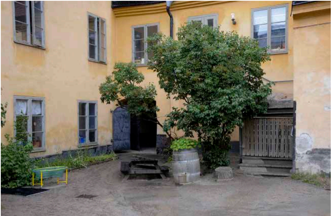
HUS 3 OCH 5 MOT GÅRDEN MED BL.A. EN ÄLDRE JÄRNDÖRR I PORTVALVET. FOTO J. MALMBERG.
