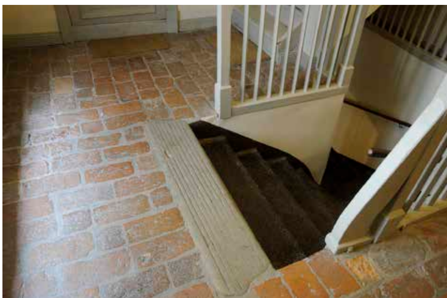
TRAPPHUSETS ÖVRE VILPLAN I HUS 3 MED ÄLDRE TEGELGOLV OCH RÄCKE. FOTO J. MALMBERG.
