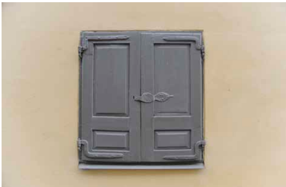
ÄLDRE FÖNSTERLUCKA I FASADEN TILL HUS 2. FOTO J. MALMBERG.
