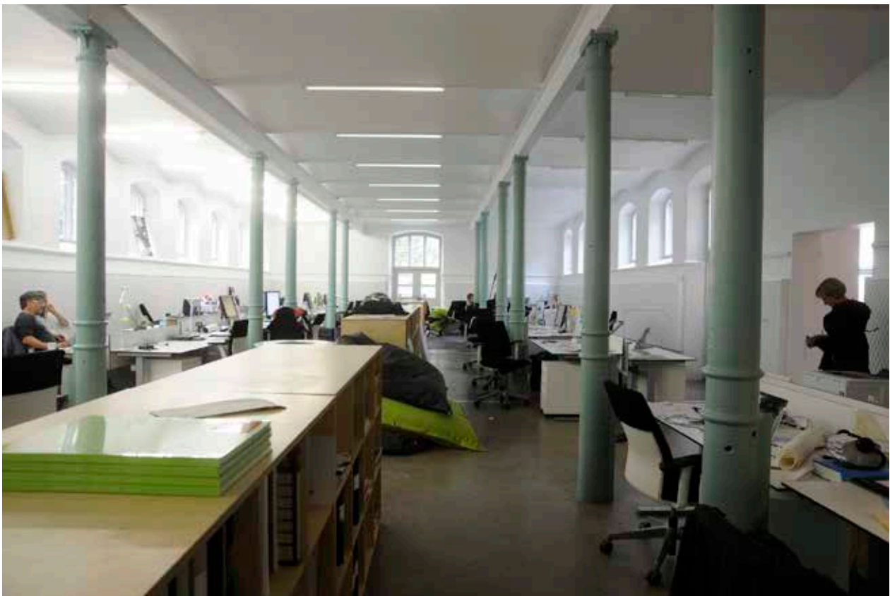
SAMMA RUM I DAG MED BLAND ANNAT BEVARADE GJUTJÄRNSKOLONNER OCH TAKETS BALKKONSTRUKTION. FOTO J. MALMBERG.
