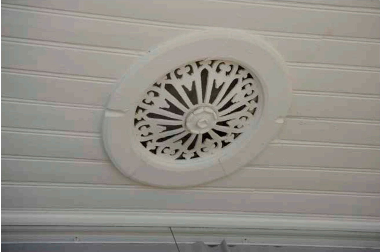
DEKORATIVT VENTILATIONSGALLER I GYMNASTIKHUSET, HUS 6, FRÅN 1880-TALET. FOTO J. MALMBERG.
