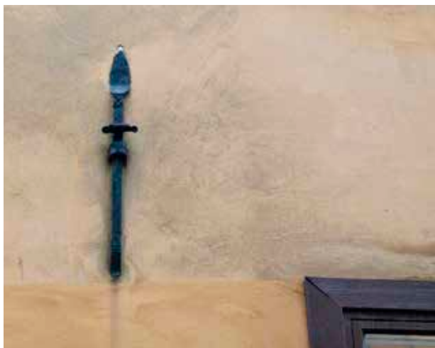
HUVUDBYGGNADENS FASADER HAR SYNLIGA ANKARSLUTAR MED BLADFORMAD AVSLUTNING. FOTO: J. MALMBERG.
