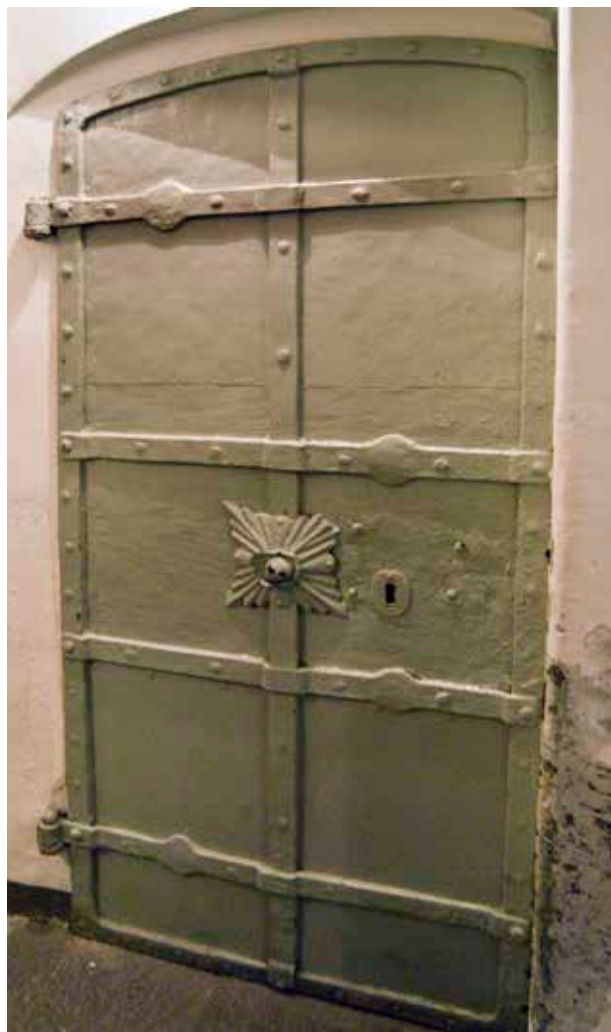
ÄLDRE, SMIDD JÄRNDÖRR TILL KÄLLAREN FRÅN PORTGÅNGEN. FOTO: J. MALMBERG.
