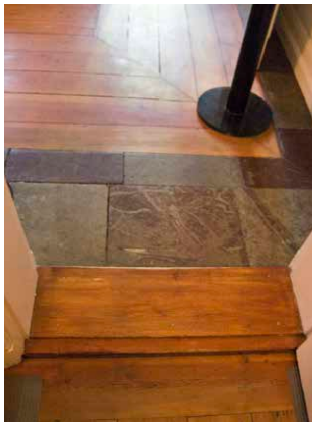
DETALJ AV TRÄGOLV MED KALKSTENSFRIS. FOTO: J. MALMBERG.
