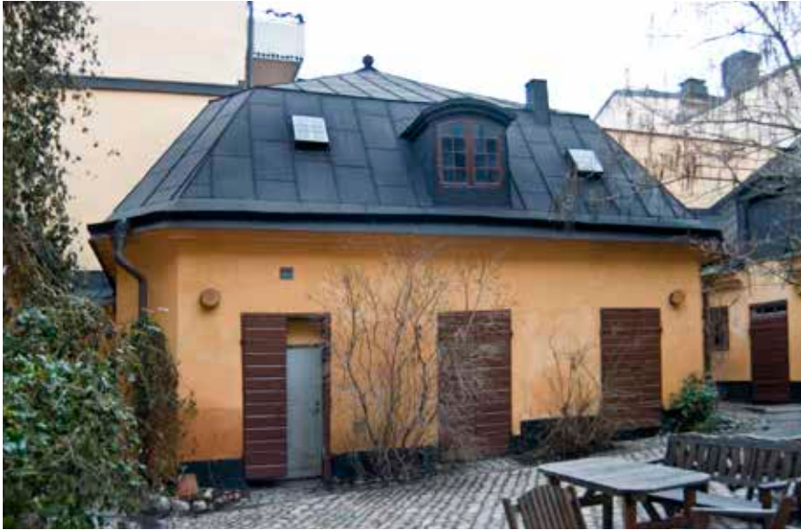
DET ÖSTRA GÅRDSHUSET HAR ETT BRUTET, VALMAT TAK MED EN DEKORATIV KULA HÖGST UPP. FOTO: J. MALMBERG
