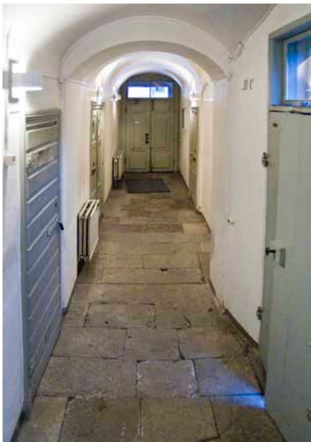
DEN KRYSSVÄLVDA PORTGÅNGEN SEDD FRÅN GÅRDEN MOT GATAN. NÄRMAST TILL VÄNSTER I BILD LÅG TIDIGARE DET ÄLDRE TRAPPLOPPET INOM HUVUDBYGGNADEN. FOTO: J. MALMBERG.
