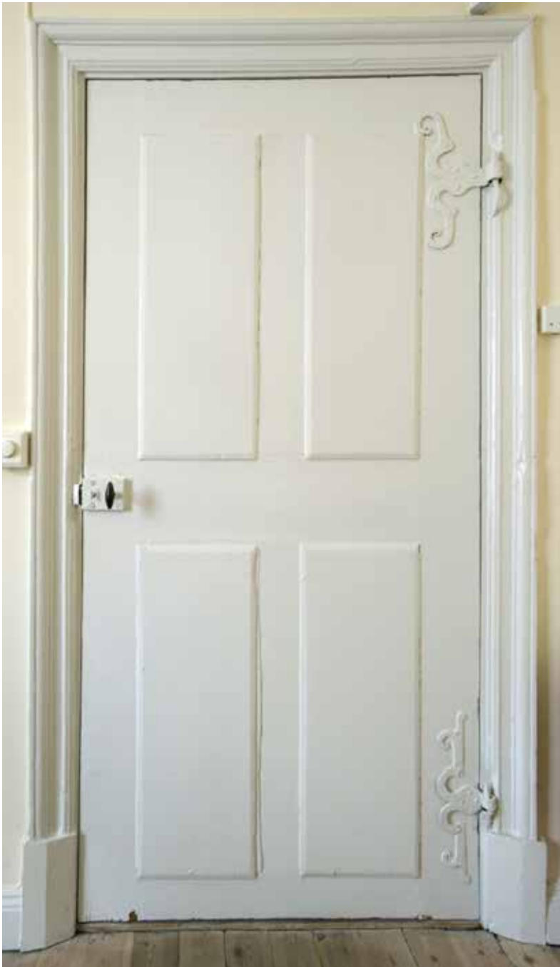
ÄLDRE ENKELDÖRR MED FYRA UTANPÅLIGGANDE Fyllningar och bockhornsbeslag. FOTO: J. MALMBERG.
