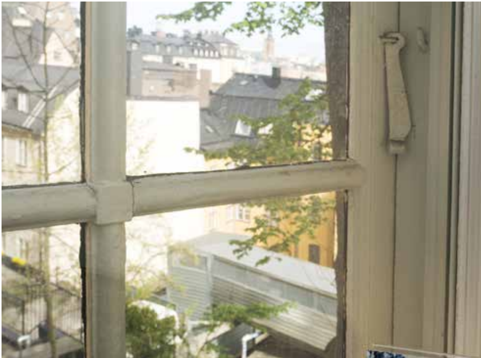
FÖNSTER AV KAROLINSK TYP MED SMÄSPRÖJS, TÄRNINGSKAPITÄL, HANDBLÅSTA GLAS OCH VINGHASPAR FRÅN OMKRING 1700. FOTO: J. MALMBERG.
