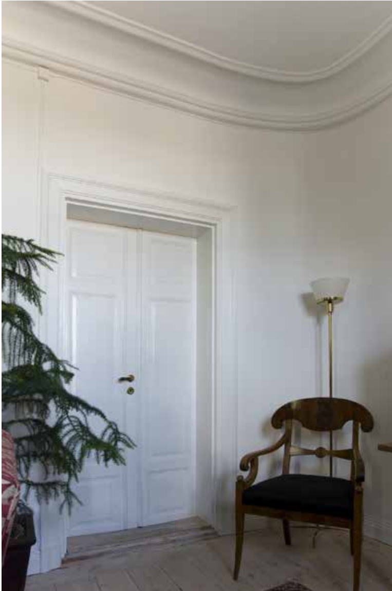
RUM MED RUNDADE HÖRN OCH BREDA HÅLKÄL MED PROFILERADE STUCKLISTER MOT VÄGG OCH TAK. PARDÖRR MED Fyllningar från 1800-TALET. FOTO: J. MALMBERG
