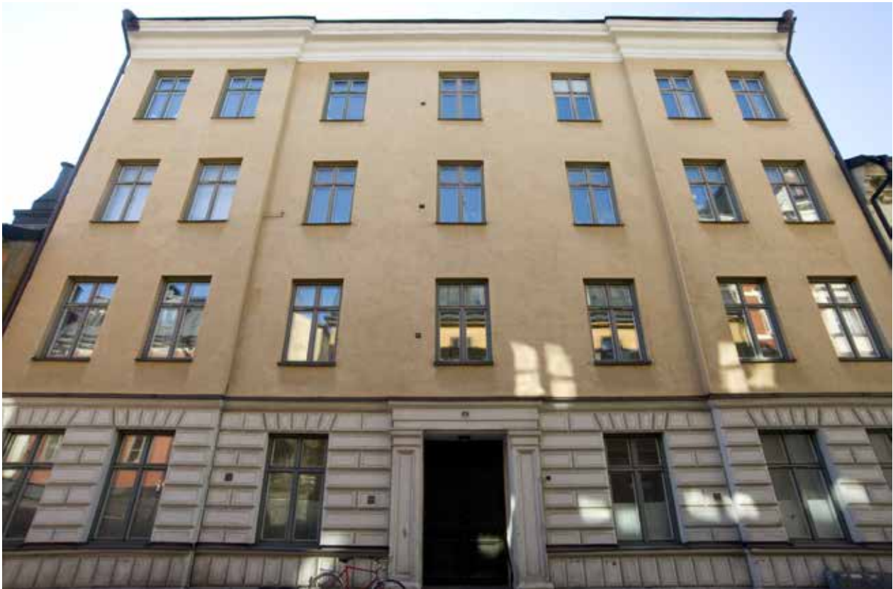
GATUFASAD MED RUSTICERAD SOCKELVÅNING, KRAFTIG TAKFOT, TVÅ UTKRAGANDE FASADPARTIER OCH EN TYDLIGT MARKERAD ENTRÉ. DE ÖVRE VÅNINGARNA HAR NEDTAGEN DEKOR. FOTO. J. MALMBERG.
