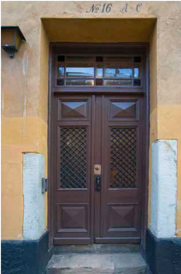
PORTEN FRÅN 1860-TALET MED PRISMADEKOR, GJUTJÄRNSGALLER OCH KULÖRTA GLASRUTOR. FOTO J. MALMBERG.
