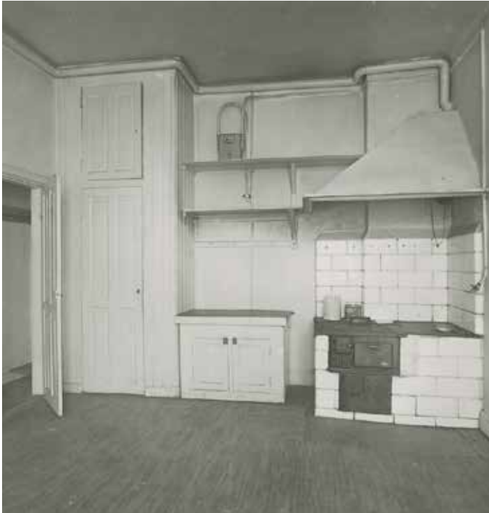
ETT AV KÖKEN FÖRE RENOVERINGEN PÅ 1970-TALET. FOTO I. GUSTAFSSON 1970, SSM F98648.
