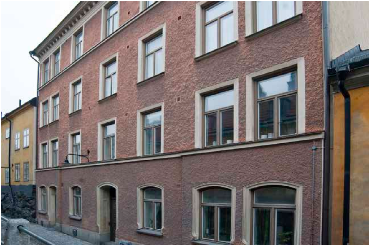
FASADEN MOT BRÄNNKYRKAGATAN. FOTO J. MALMBERG.
