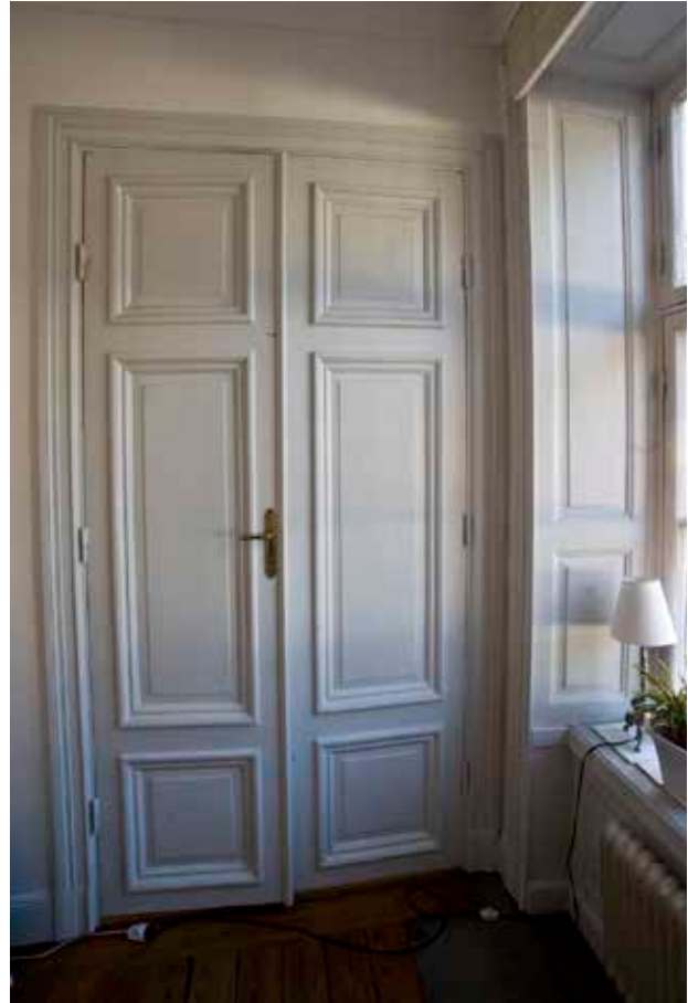
PARDÖRR OCH FÖNSTERSMYGPANEL. FOTO J. MALMBERG.
