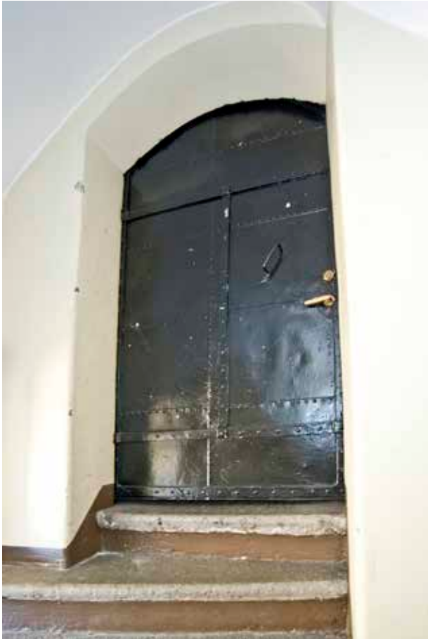
JÄRNPLÅTSBESLAGEN DÖRR I TRAPPHUSET. FOTO J. MALMBERG.
