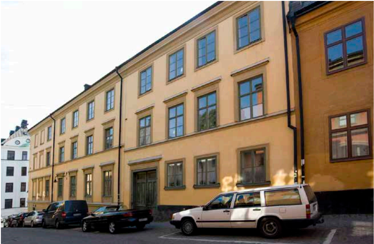
FASADEN MOT BELLMANSGATAN. MÄRTEN STREHLITZ HUS OMFATTAR SANNOLIKT DE NÄRMASTE FYRA FÖNSTERAXLARNÄ. FOTO J. MALMBERG.
