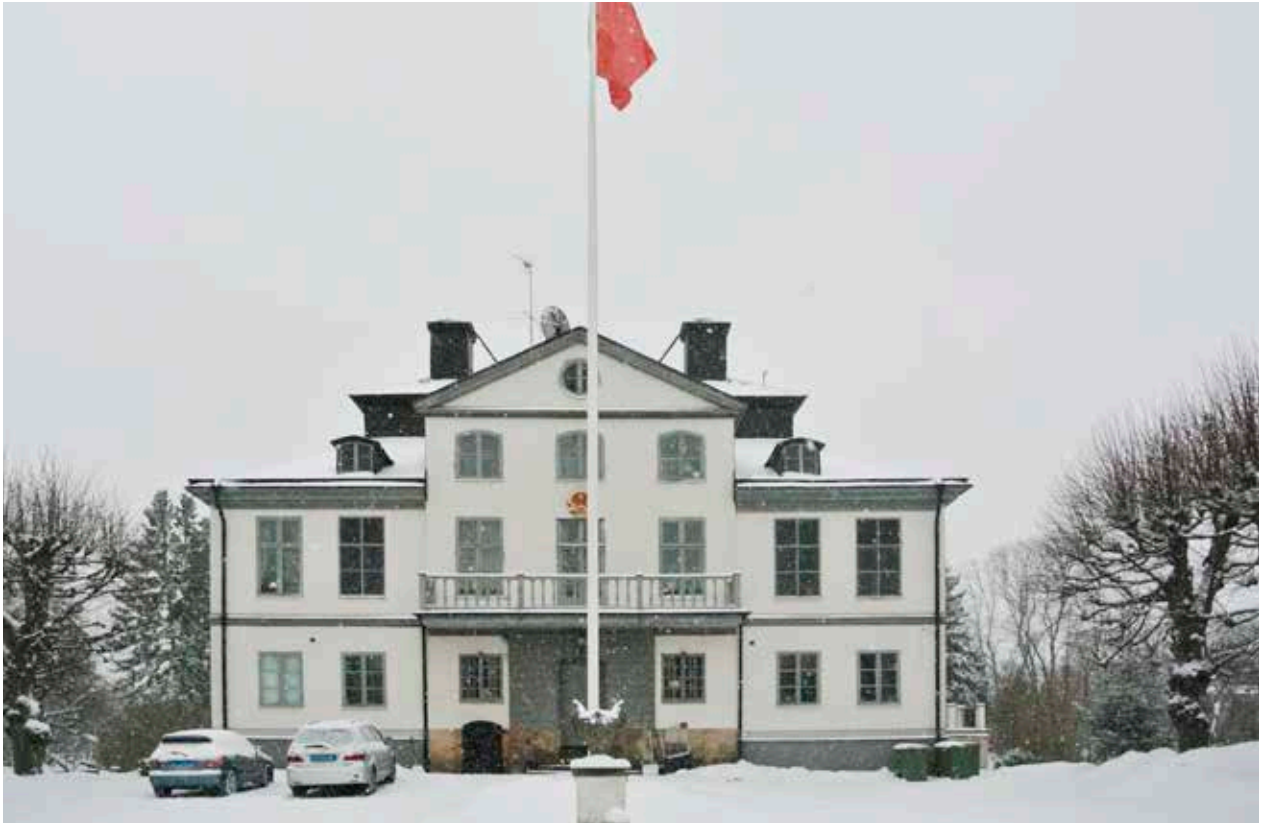
HUVUDBYGGNADEN OCH FLYGLARNA HAR SEDAN 1974 VARIT VIETNAMS AMBASSAD. DET FRAMSKJUTANDE PARTIET (FRONTESPISEN) TILLKOM UNDER SENT 1700-TAL. FOTO: J. MALMBERG.
