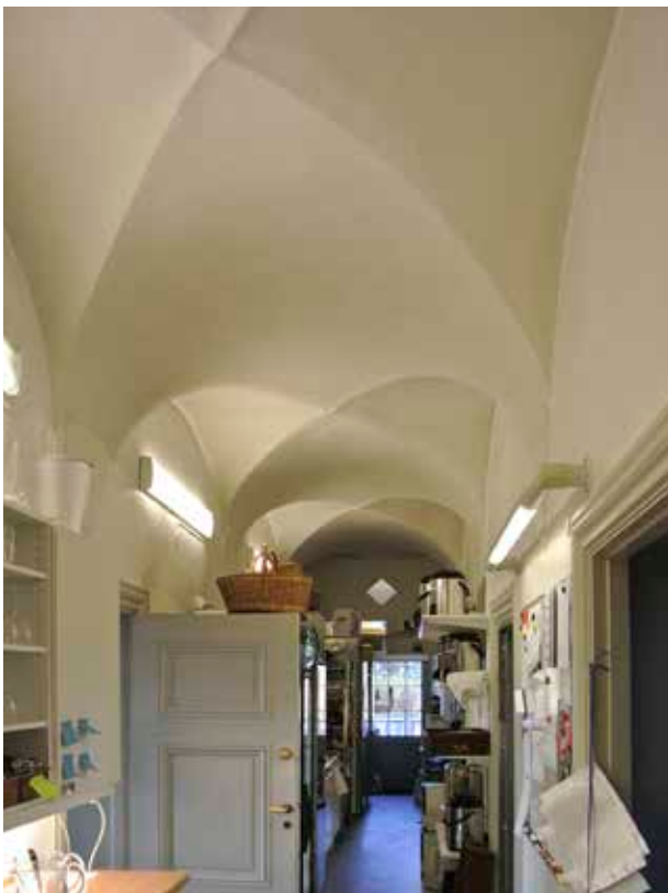
I BOTTENVÅNINGEN FINNS VALV FRÅN HUSETS UPPFÖRANDE PÅ 1600-TALET, ETT AV FÅ SPÅR AV DEN ÄLDSTA INREDNINGEN. FOTO: J. MALMBERG.
