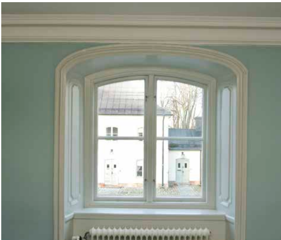
I DEN ÖSTRA FLYGELN FINNS TAK-LISTER OCH FÖNSTER-SNICKERIER AV 1700-TALSTYP BEVARADE. FOTO: J. MALMBERG.
