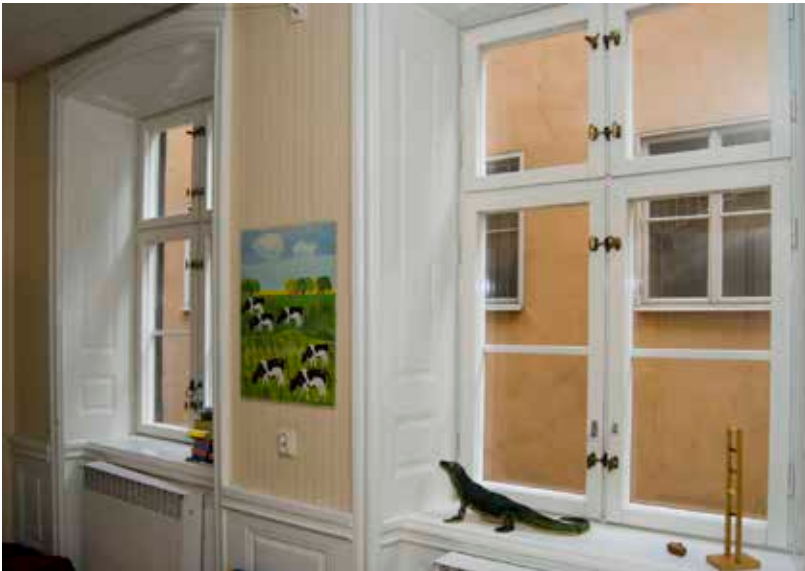
FÖNSTERPANELER, BRÖSTPANEL OCH FÖNSTERFODER FRÅN 1700-TALET. FOTO: J. MALMBERG.
