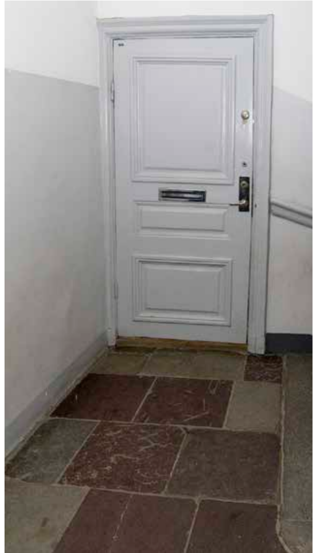
HELFRANSK ENKELDÖRR MED KRAFTIGT PROFILERAT FODER FRÅN 1700-TALET. FOTO: J. MALMBERG.
