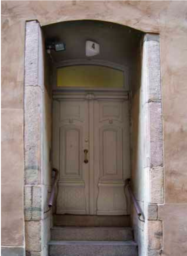
KRAFTIGT INDRAGEN PORT MED SIDOSTYCKEN AV STEN. DEN HELFRANSKA PARDÖRREN ÄR FRÅN 1700-TALETS SENARE HÄLFT. FOTO: J. MALMBERG.
