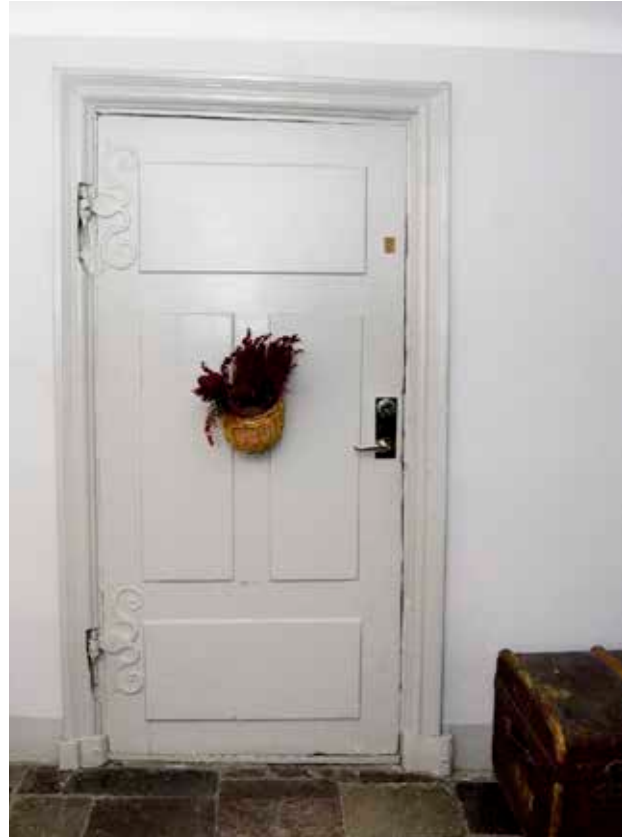
DÖRR MED FYRA UTANPÅLIGGANDE Fyllningar och S-formade gångjärnsbeslag från 1600-talet. Foto: J. Malmberg.
