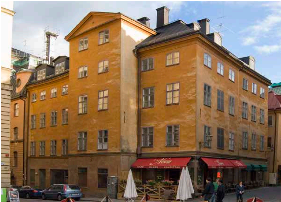
FASADEN PÅ FÖRE DETTA NARCISSUS 3 MOT JÄRNTORGET. MOT NORR FINNS ETT BETONAT MITTPARTI, TVÅ FÖNSTERAXLAR BRETT. FOTO: J. MALMBERG.
