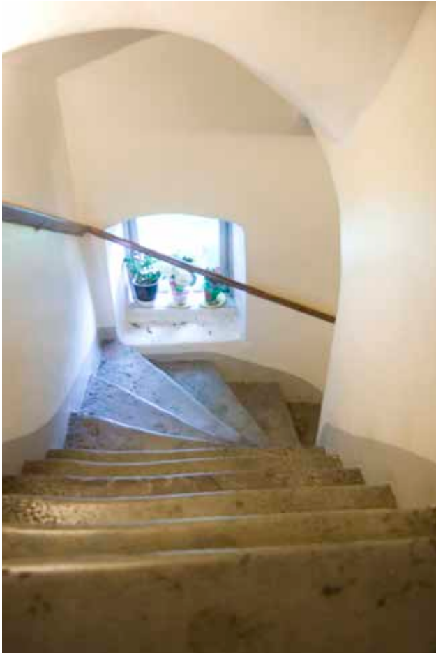
TRAPPHUSET HAR NÖTTA TRAPPSTEG AV KALKSTEN OCH EN HANDELDARE AV ÄLDRE MODELL. FOTO J. MALMBERG.
