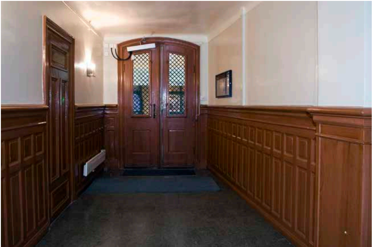
PORTGÅNGEN FLYTTADES TILL SITT NUVARANDE LÄGE PÅ 1880-TALET. PARDÖRREN OCH DEN HÖGA VÄGGPANELEN ÄR FRÅN DENNA TID. FOTO: J. MALMBERG.
