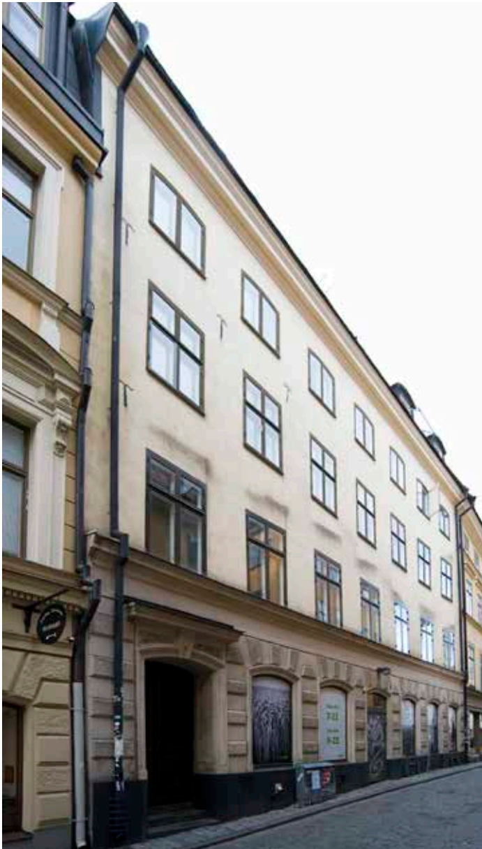
HUVUDBYGGNADEN FICK SIN NUVARANDE HÖJD CA 1750 DÅ DEN ÖVERSTA VÅNINGEN UPPFÖRDES. FOTO: J. MALMBERG.
