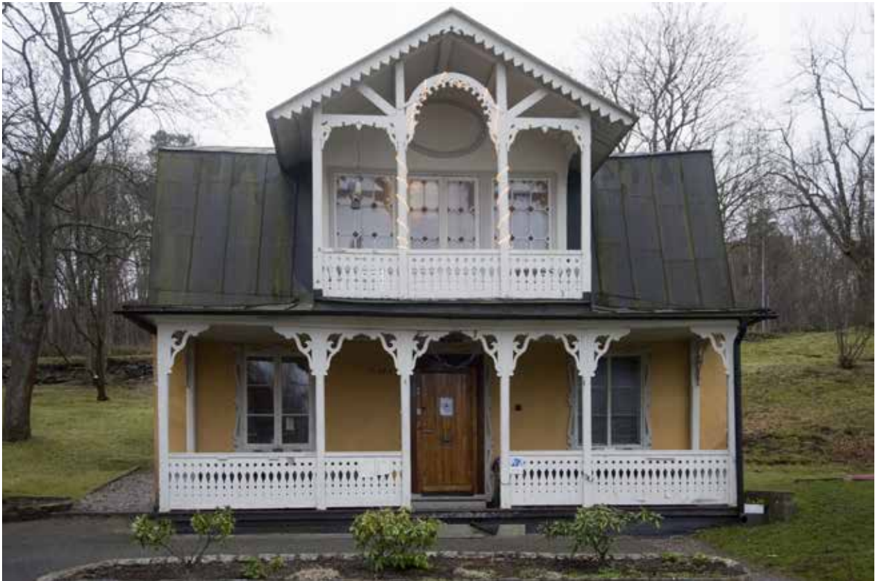
ANNEXETS GÅRDSFASAD MED VERANDANS KONTURSÅGADE SNICKERIER OCH FÄRGADE GLASRUTOR. FOTO J. MALMBERG.
