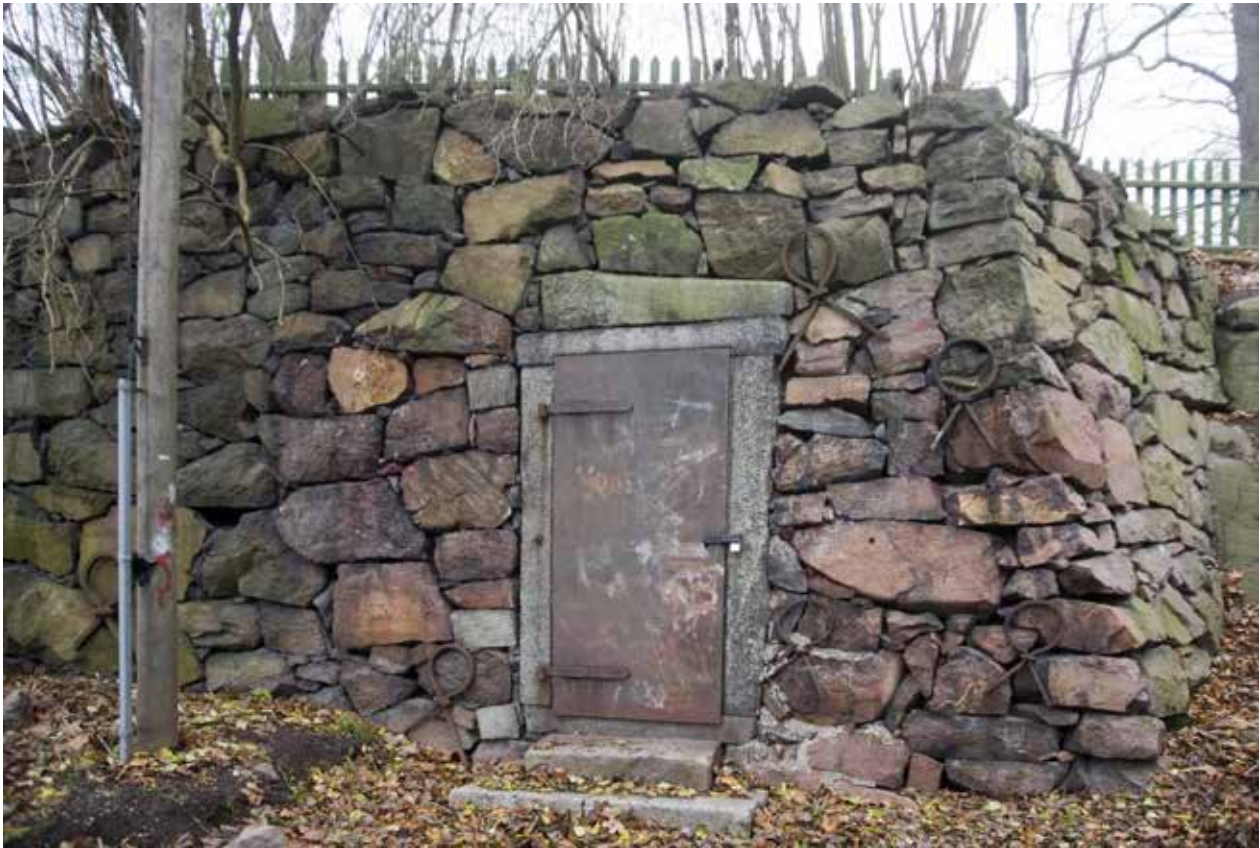
MURAD FÖRE DETTA KÄLLARE STRAX ÖSTER OM HUVUDBYGGNADEN. FOTO J. MALMBERG.
