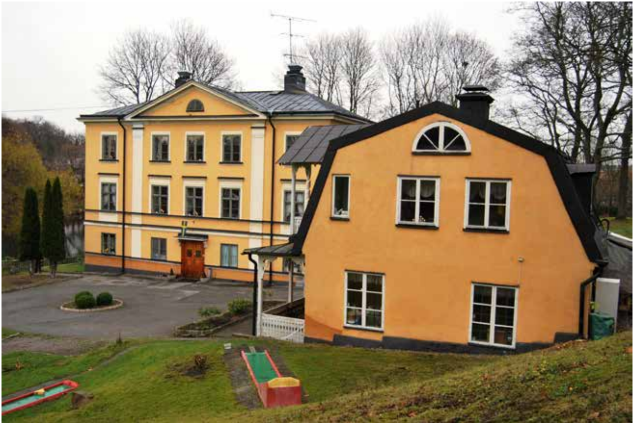
HUVUDBYGGNADEN OCH ANNEXET. LÄGG MÄRKE TILL DEN OREGELBUNDNA FÖNSTERSÄTTNINGEN PÅ ANNEXETS GAVEL. FOTO B. NORDENMARK.
