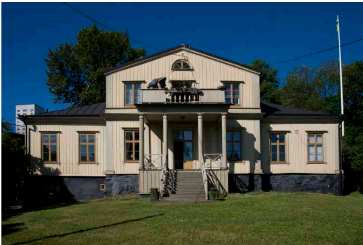
BYGGNADENS ÖSTRA FASAD MED UTSIKT ÖVER VATTNET. FOTO: J. MALMBERG
