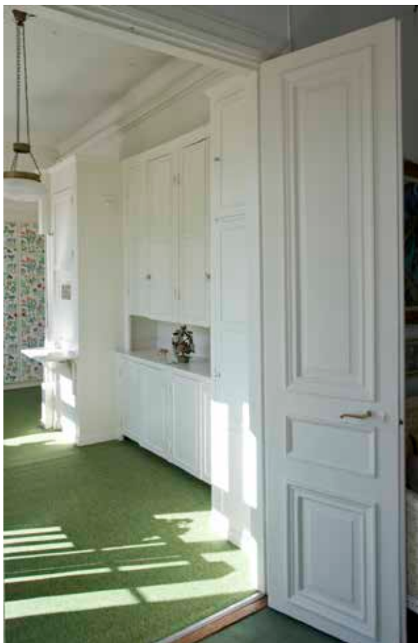
PLATSBYGGDA SKÅP I SERVERINGSGÅNGEN OCH URSPRUNGLIG HELFRANSK PARDÖRR. FOTO: J. MALMBERG
