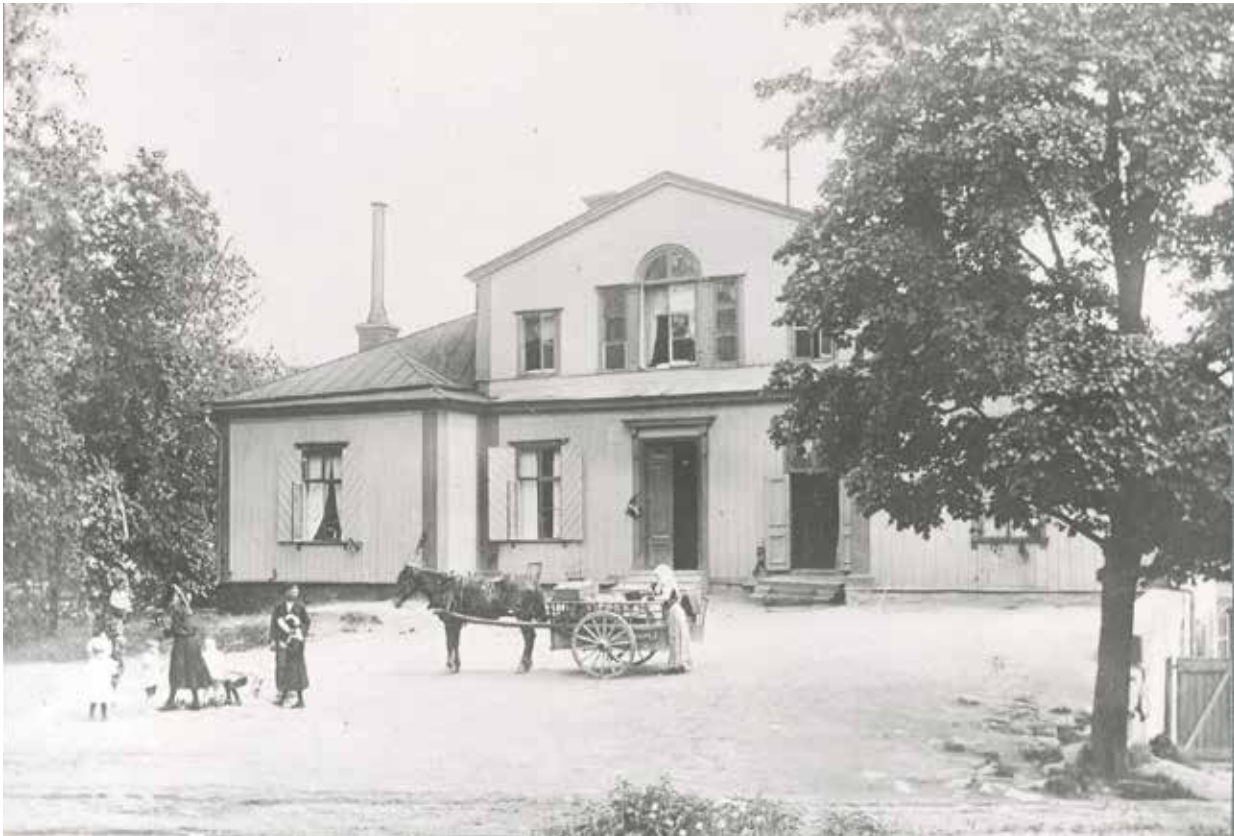
HUSET OMKRING ÅR 1902. PÅ BILDEN SYNS DE TVÅ ENTRÉERNA. DEN HÖGRA SATTES IGEN UNDER 1920-TALET. FOTO: E THOMÉÉ. SSMF33754
