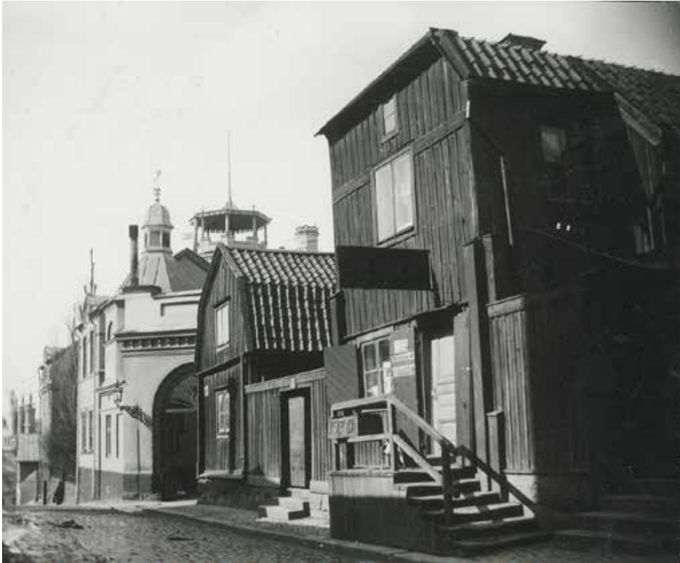
DET RIVNA HUSET PÅ LUDVIGSBERGSGATAN 14. I BAKGRUNDEN SKYMTAR LUDVIGSBERGSGATAN 16 OCH DISPONENTVILLAN TILL LUDVIGSBERGS MEKANISKA VERKSTAD. FOTO O. HEIMER 1905, SSM F87554.
