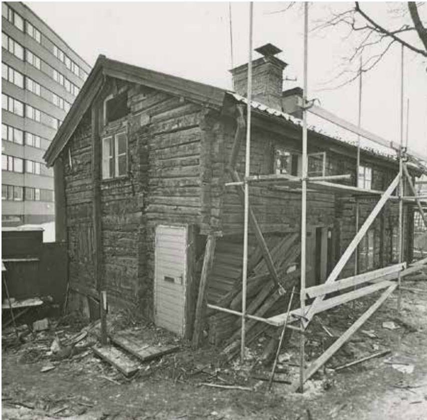
LUDVIGSBERGSGATAN 12 UNDER RESTAURERING I MARS 1968. FOTO G. FREDRIKSSON SSM F 82244.
