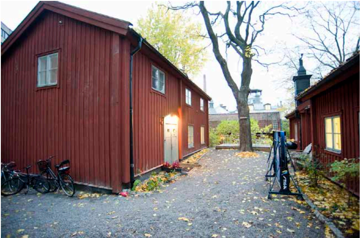
DEN GRUSADE GÅRDSPLANEN VID LUDVIGSBERGSGATAN 12 MED BOSTADSHUSET T.V. OCH DE TVÅ SAMMANBYGGDA UTHUSEN T.H. FOTO J. MALMBERG.
