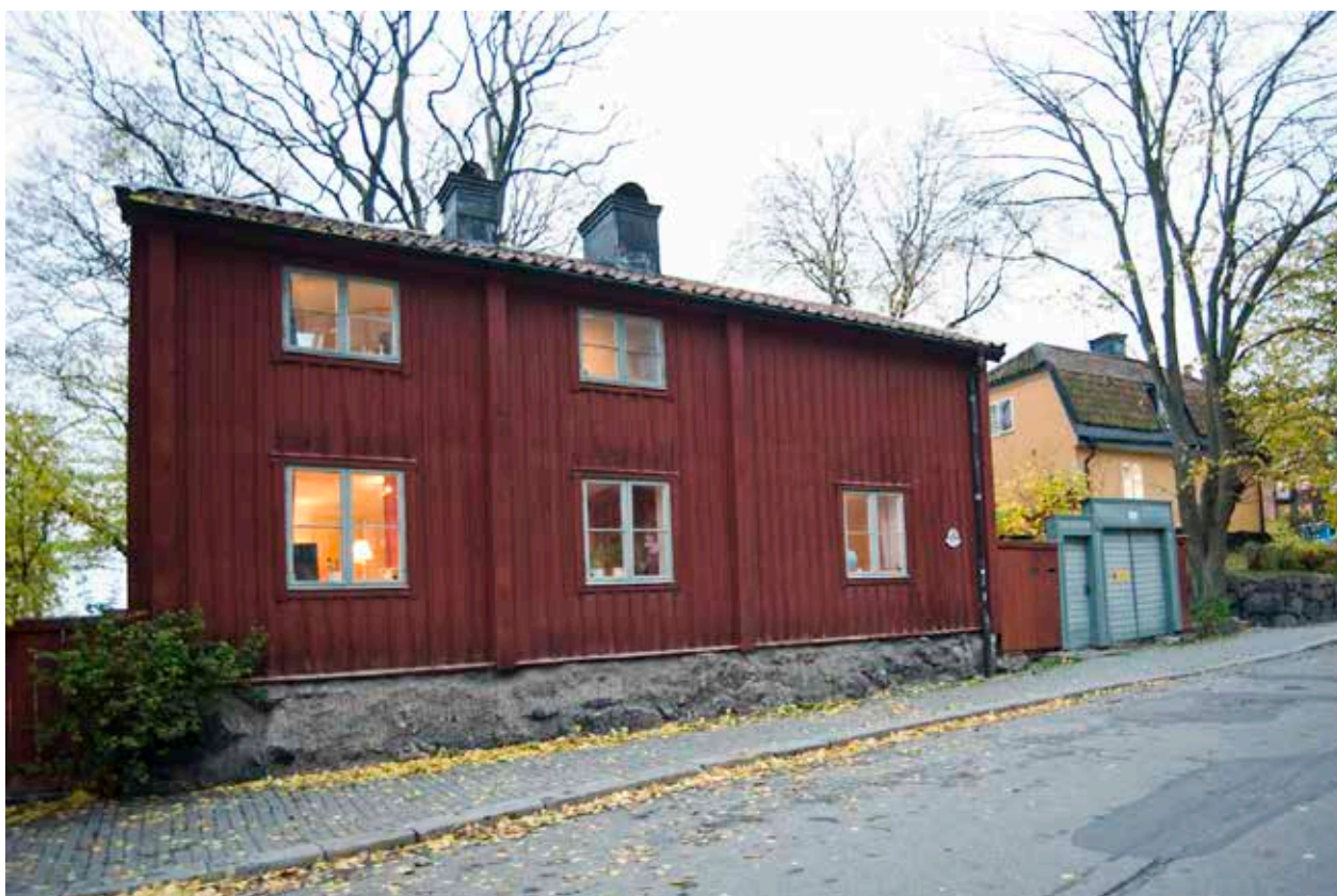
BOSTADSHUSET VID LUDVIGSBERGSGATAN 12. FOTO J. MALMBERG.
