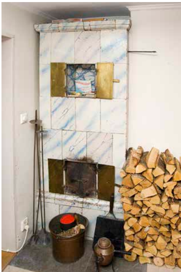
EN ÄLDRE KAKELUGN MED LITET VÄRMESKÅP PÅ LUDVIGSBERGSGATAN 12. FOTO J. MALMBERG.
