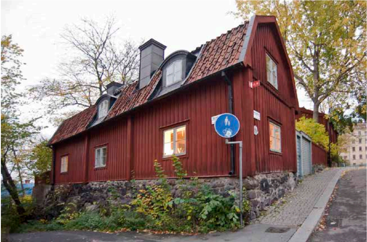
BOSTADSHUSET VID LUDVIGSBERGSGATAN 16 SOM LIGGER MED LÅNGSIDAN MOT DUVOGRÄND. FOTO J. MALMBERG.
