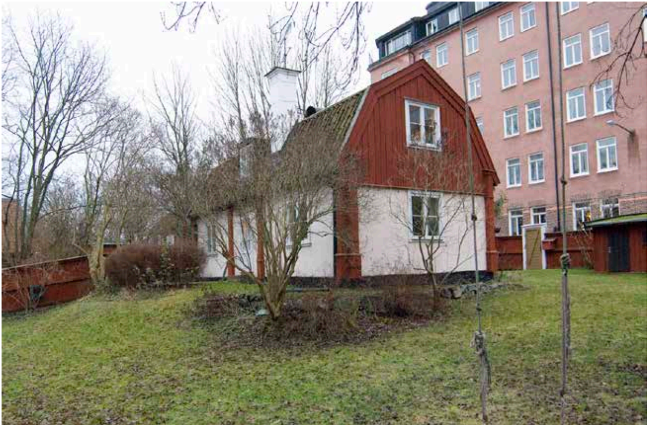
LOTSEN 19. GÅRDHUSET SETT FRÅN TOMTEN OCH NORDVÄST. BOTTENVÅNINGEN ÄR SLÄTPUTSAD MED PROFILERADE TRÄPILASTRAR SOM MARKERAR KNUTKEDJOR. FOTO: J. MALMBERG.
