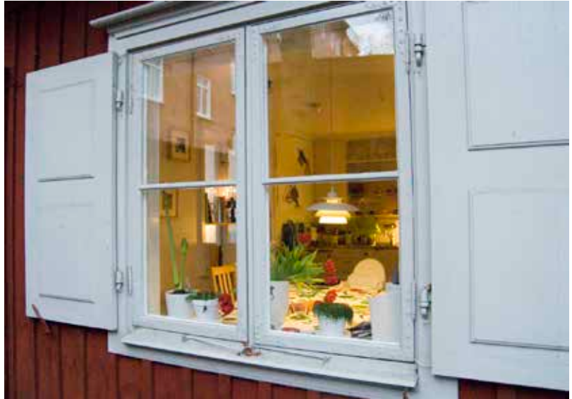
LOTSEN 18. FÖNSTRET HAR BESLAG AV 1700-TALSTYP SOM KAN VARA FRÅN RENOVERINGEN 1959 DÅ FÖNSTERLUCKORNA BYTTES. FOTO: J. MALMBERG.
