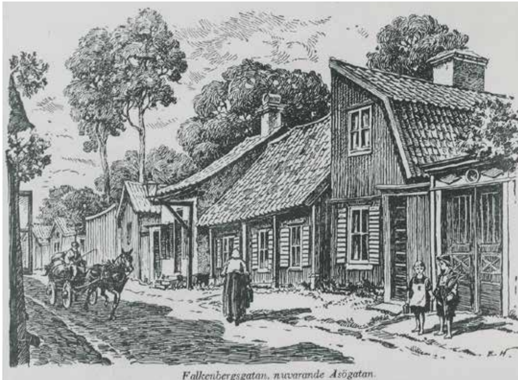
TECKNING AV ÅSÖGATAN MED LOTSEN 18 NÄRMAST TILL HÖGER I BILD. OKÄND KONSTNÄR OCH ÅR. SSM:S ARKIV A175/42
