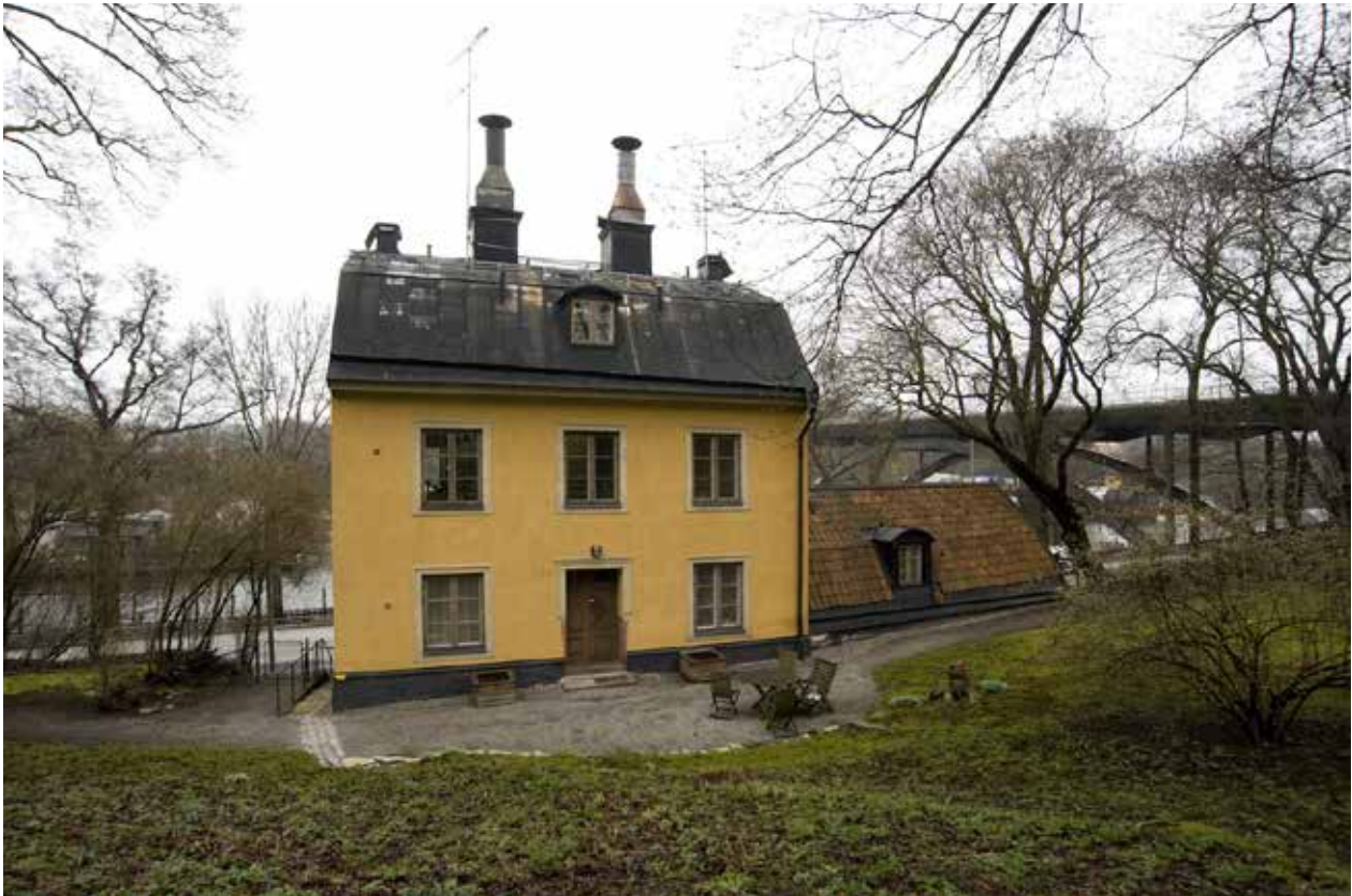
FASAD MOT SÖDER MED URSPRUNGLIG PARPORT. FOTO. J. MALMBERG.
