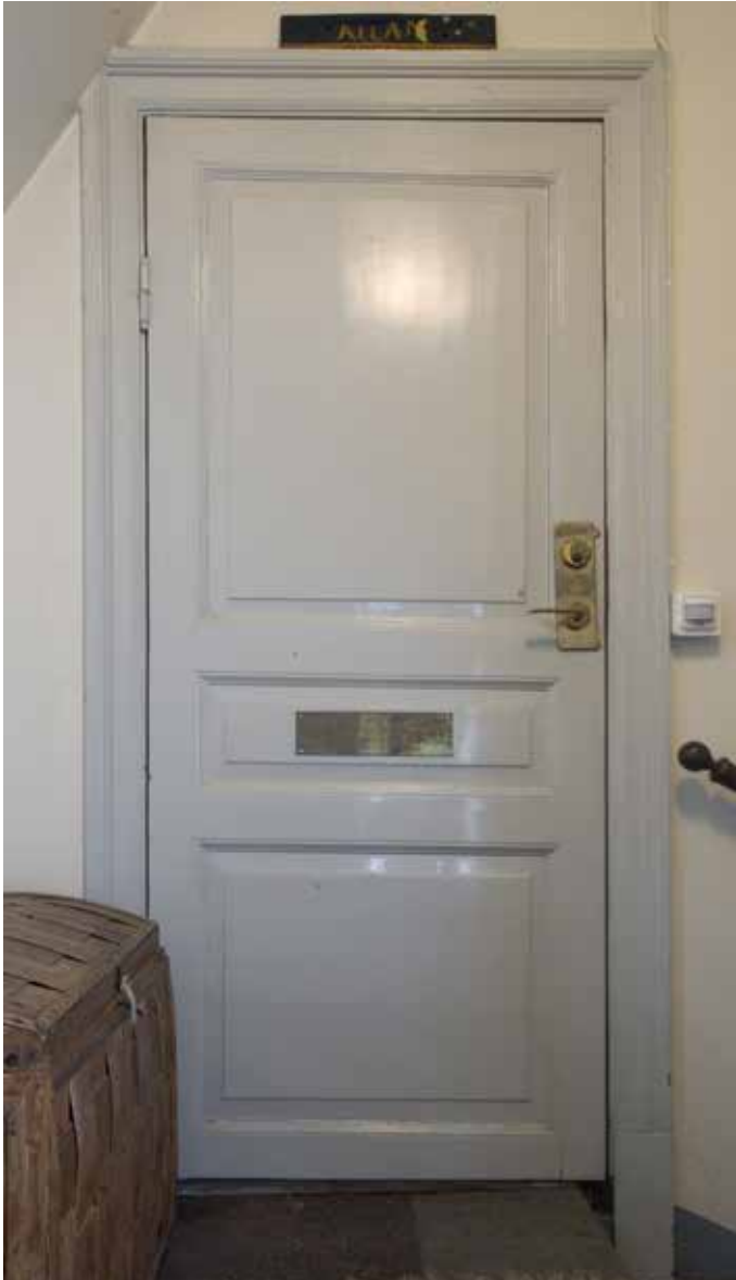
URSPRUNGLIG LÄGENHETSDÖRR MED TRE HALVFRANSKA FYLLNINGAR, GÅNGJÄRN MED KULKNOPP OCH SAMTIDA PROFILERADE FODER. VILPLANET ÄR LAGT MED KALKSTENS-PLATTOR. FOTO. J. MALMBERG.
