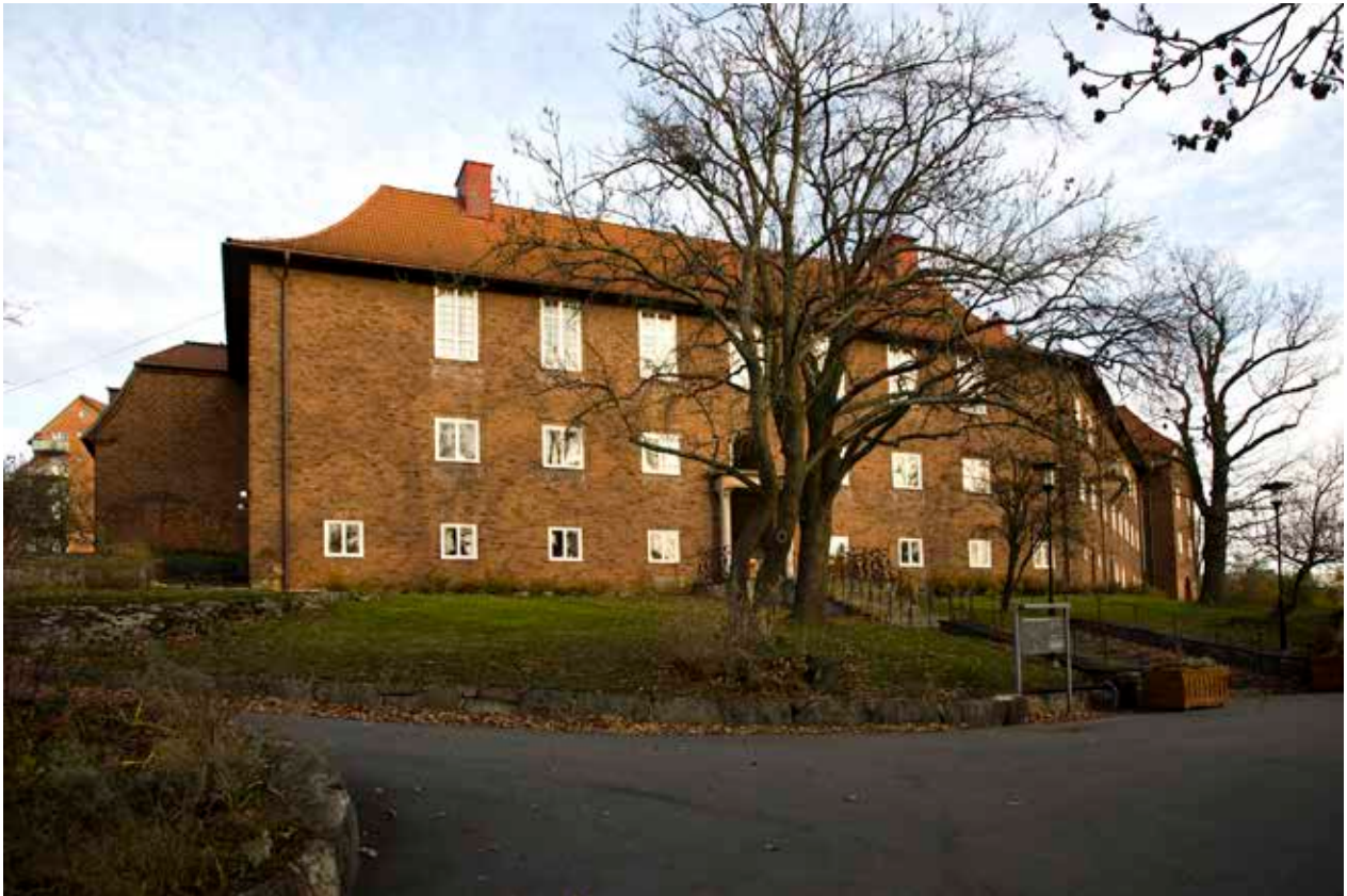
BYGGNADEN ÄR VÄL SYNLIG, UPPFÖRD MED STOR HÄNSYN TILL BERGETS TERRÄNGFORMATION OCH ETT STÅTLIGT INSLAG PÅ SIN HÖJD OVANFÖR LILJEHOLMENS CENTRUM. FOTO: J. MALMBERG
