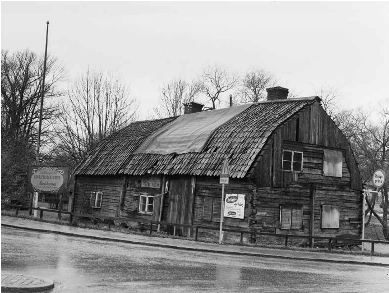
LILLA HORNSBERG I NOVEMBER 1953, STRAX INNAN RENOVERINGEN BÖRJAR. FOTO J. KJELLSTRÖM, SVD, SSMSVD36082.
