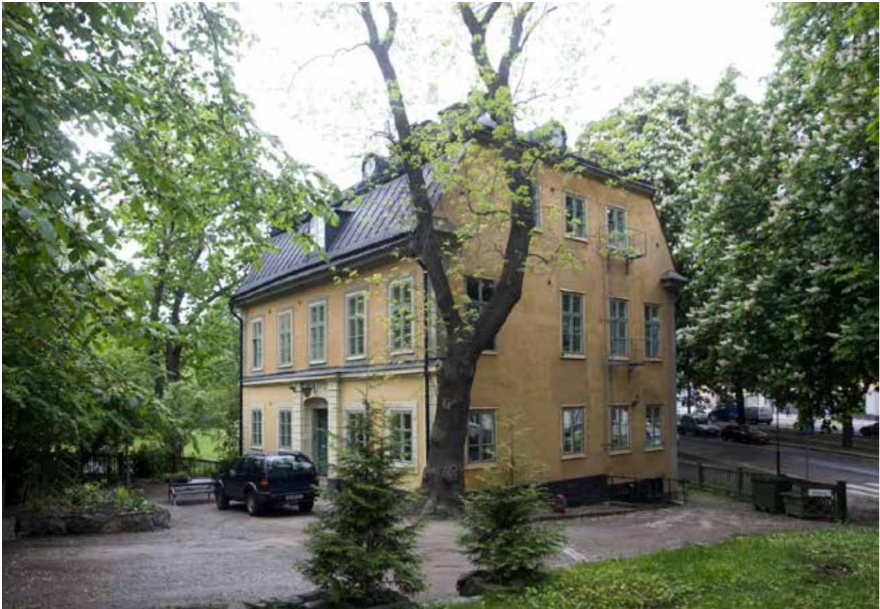
LILLA BLECKTORNET HAR SIN 1700-TALSKARAKTÄR BEVARAD MED BRUTET TAK, SLÄTPUTSADE MURAR OCH FÖNSTER I MURLIVET. TAKET VAR URSPRUNGLIGEN TÄCKT MED TEGEL. FOTO J. MALMBERG.
