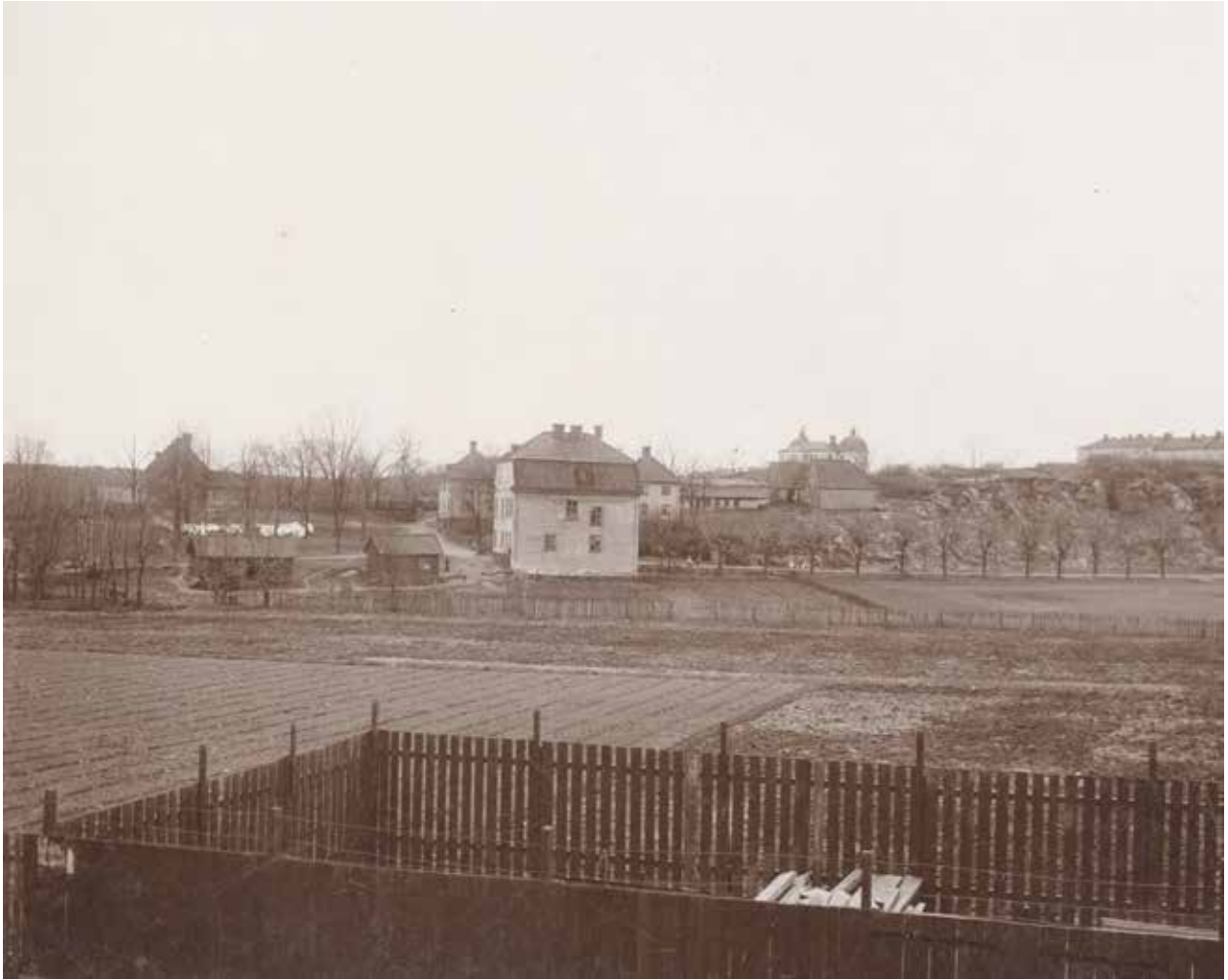
UTSIKT FRÅN MALMGÅRDSVÄGEN MOT LILLA BLECKTORNET. I BAKGRUNDEN SKYMTAR STORA BLECKTORNET. FOTO 1902, SSM FA39483
