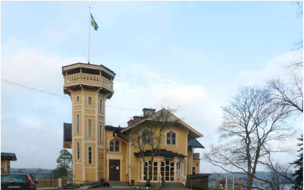
VILLA LYRAN MED MÄLAREN I BAKGRUNDEN. TORNETS TAK ÄR KONSTRUERAT FÖR ATT VARA HÖJ- OCH SÄNKBART. AV TRÄDGÅRDEN FINNS ENDAST RESTER KVAR. FOTO: J. MALMBERG.
