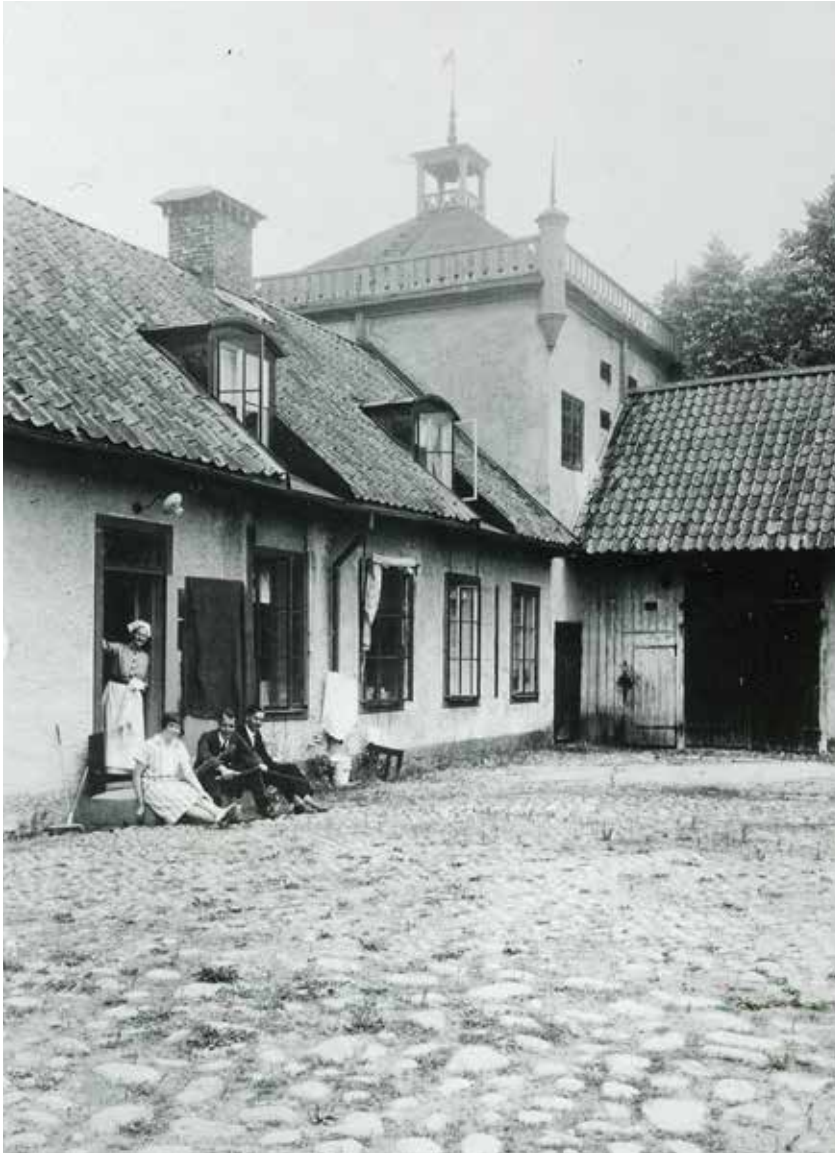
VÄSTRA TORNET MED VÄLLINGKLOCKAN PÅ TAKET. KLOCKAN KALLADE SAMMAN TILL ARBETE OCH MÅLTIDER MEN FINNS INTE LÄNGRE KVAR. FOTO G. SELLING, TROL. 1920-TAL, SSM F74027.
