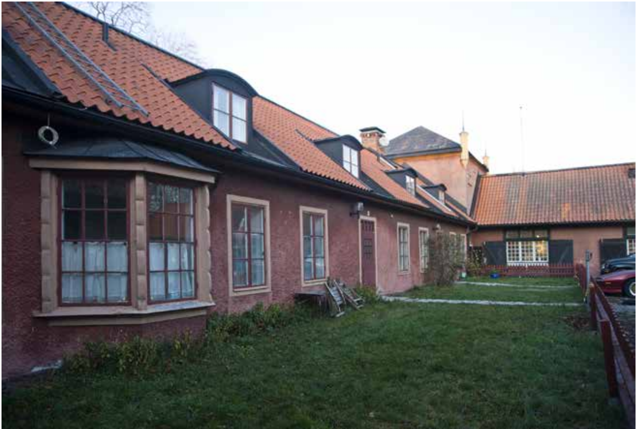
NORRA BOSTADSLÄNGAN MED BURSPRÅKET FRÅN 1880-TALET NÄRMAST. TAKET ÄR RELATIVT NYLAGT MED ENKUPIGT TEGEL OCH TAKKUPORNA HAR FÅTT NY PLÅTBEKLÄDNAD. FOTO J. MALMBERG.
