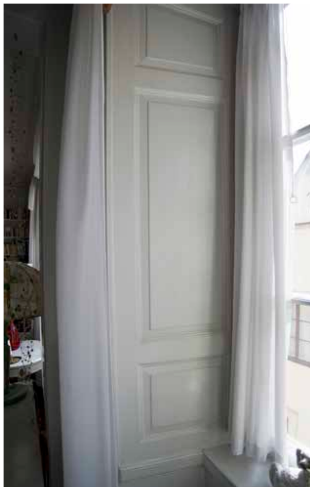
FÖNSTERÖPPNINGARNA HAR HALVFRANSKA FÖNSTERSMYGPANELER FRÅN 1860-TALET. FOTO: J. MALMBERG.
