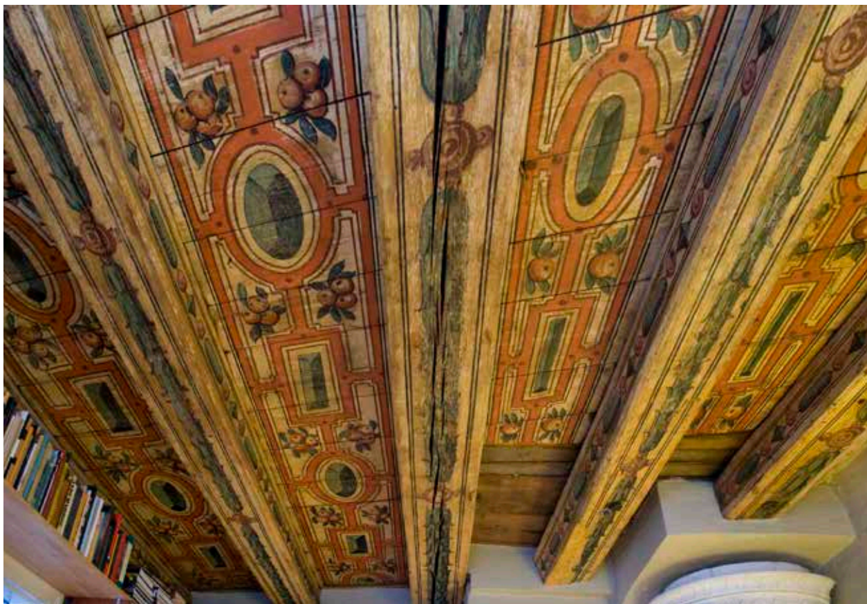
DET MÅLADE BJÄLKTAKET MED PANELBRÄDOR ÄR FRÅN TIDIGT 1600-TAL. DET TOGS FRAM OCH KONSERVERADES PÅ 1970-TALET. FOTO: J. MALMBERG.
