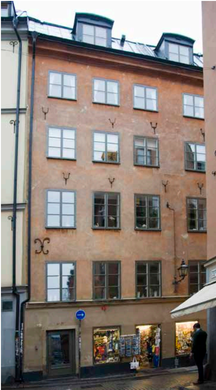
FASADEN MOT VÄSTERLÅNGGATAN HAR EN ENKEL PRÄGEL OCH FLERA SYNliga ANKARSLUTAR FRÅN 1600-TALET. FOTO: J. MALMBERG.
