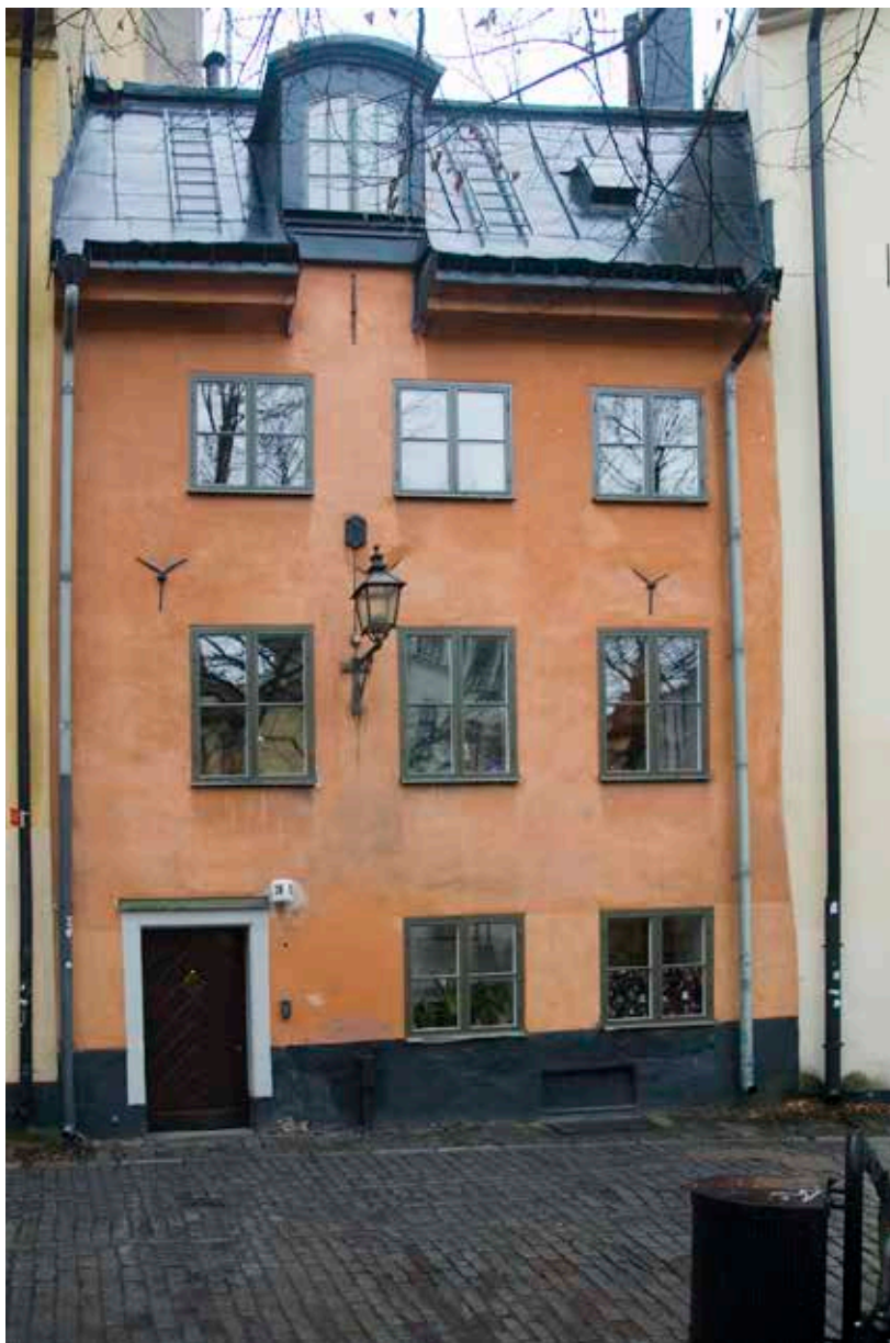
MOT PRÄSTGATAN ÄR FÖNSTERÖPPNING- ARNA MINDRE ÄN MOT VÄSTERLÄNGGATAN, OCH ÅT DENNA SIDA LÄG DE ENKLARE RUMMEN. FOTO: J. MALMBERG.
