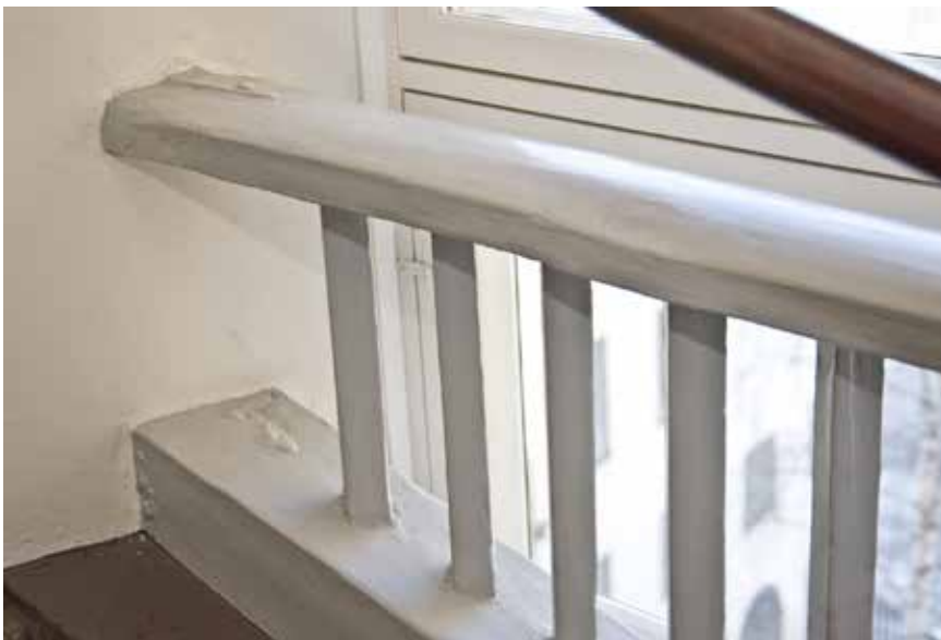
RÄCKE FRÅN 1700-TALET I GATHUSETS TRAPPA, MED RUNDAD ÖVERLIGGARE OCH SMIDDA INFÄSTNINGAR I VÄGGEN. FOTO: J. MALMBERG.
