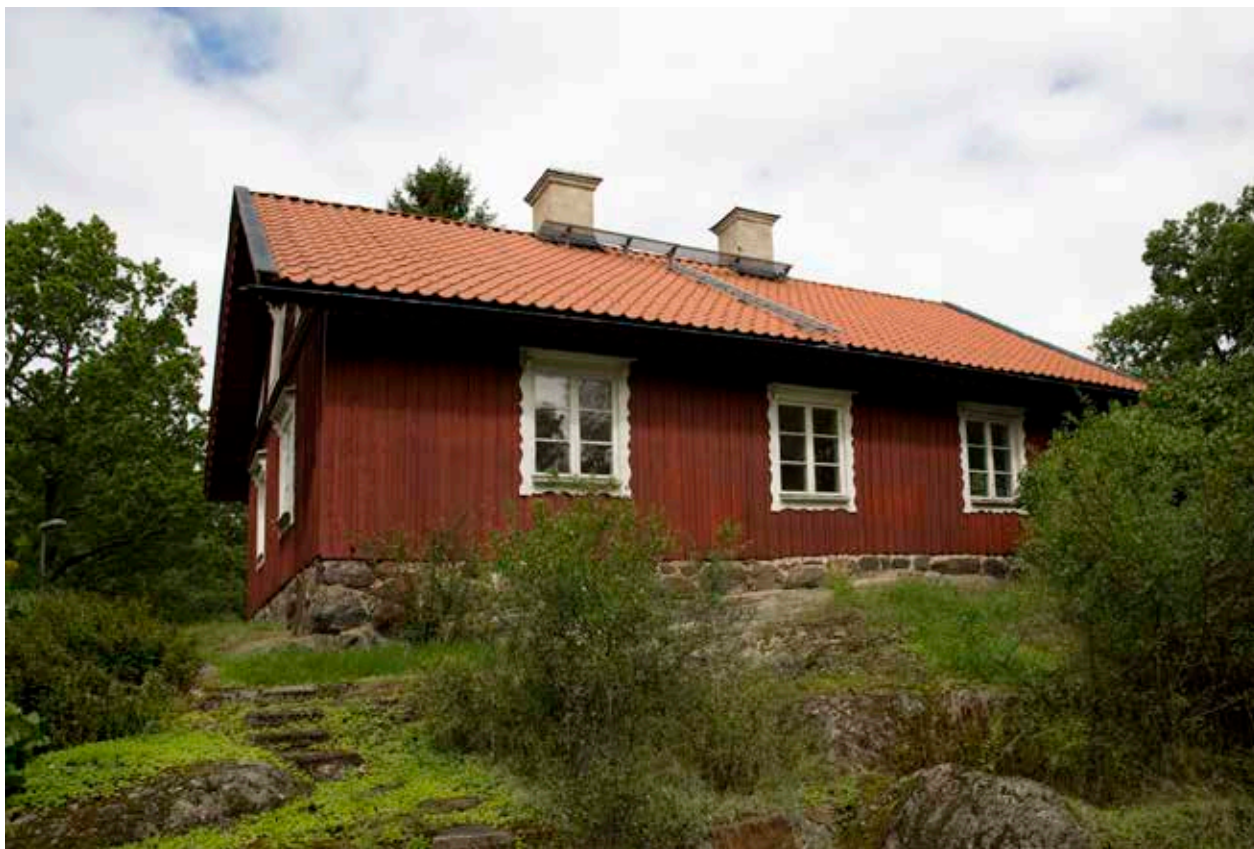
OMKRING DEN FÖRE DETTA ARBETARBOSTADEN FINNS SPÅR AV ÄLDRE TRÄDGÅRDSANLÄGGNING. FOTO: J. MALMBERG
