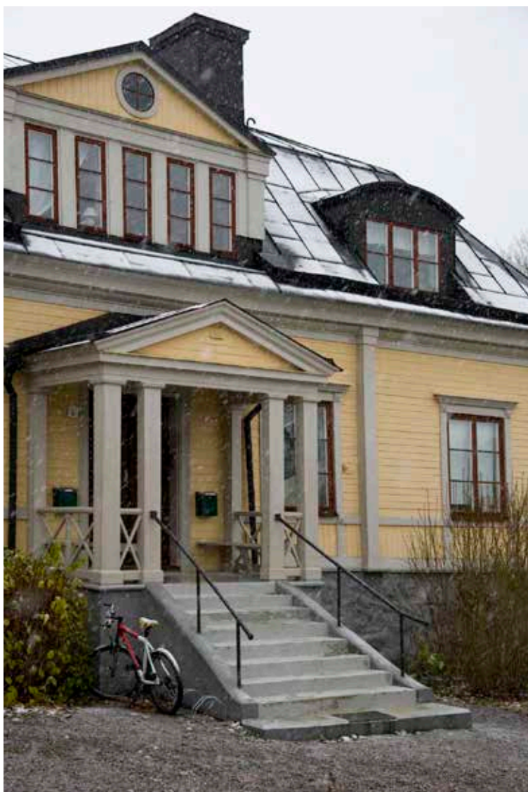
FLYGELBYGGNADEN MED ENTRÉ MOT SÖDER. FOTO: J. MALMBERG
