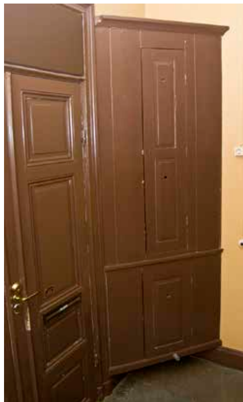
TRAPPHUSET VID SVARTENSGATAN 38B MED SKÅP OCH LÄGENHETSDÖRR FRÅN BYGGNADSTIDEN. FOTO J. MALMBERG.
