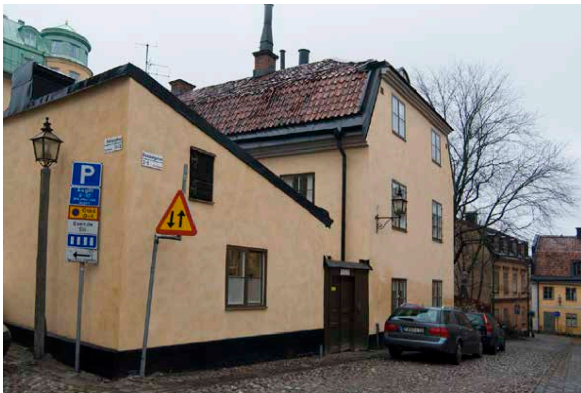
RODDARGATAN 3 MED GAVEL MOT GATAN OCH NÄRMAST LÄNGAN FRÅN 1834. FOTO J. MALMBERG.
