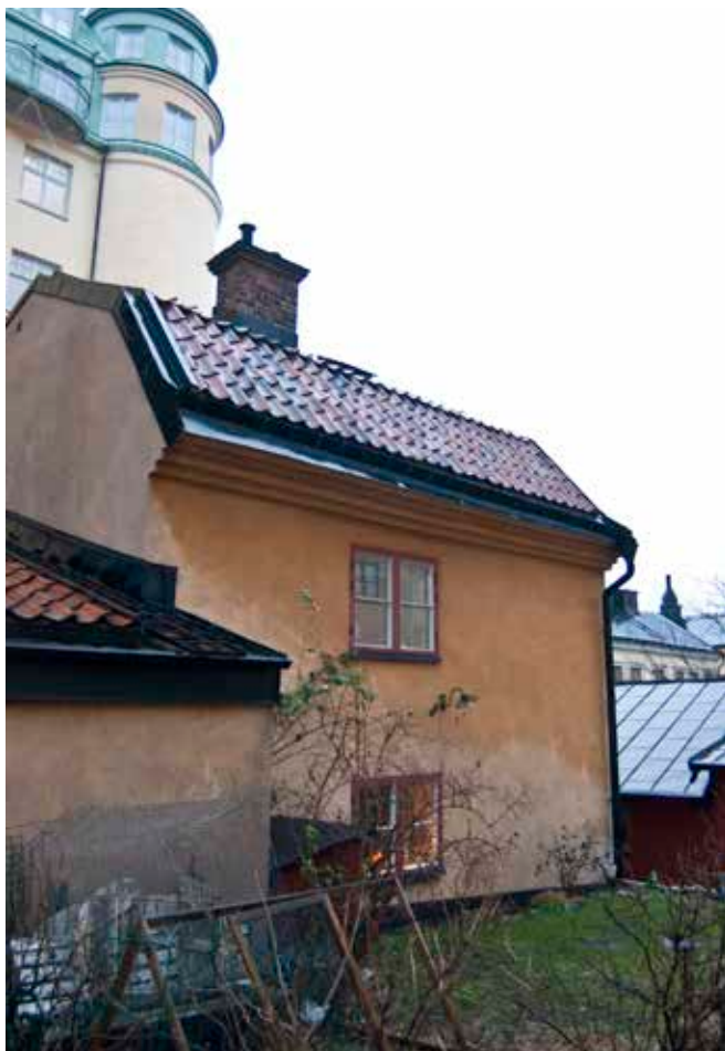
GÅRDSFASADEN TILL STENHUSET VID SVARTENSGATAN 34A. FOTO J. MALMBERG.
