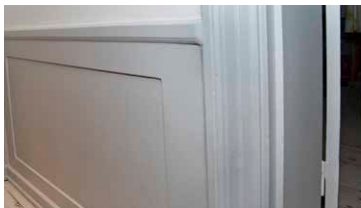
STENPROFILERAD PANEL FRÅN 1790-TALET SLUT VID RODDARGATAN 3. FOTO J. MALMBERG.
