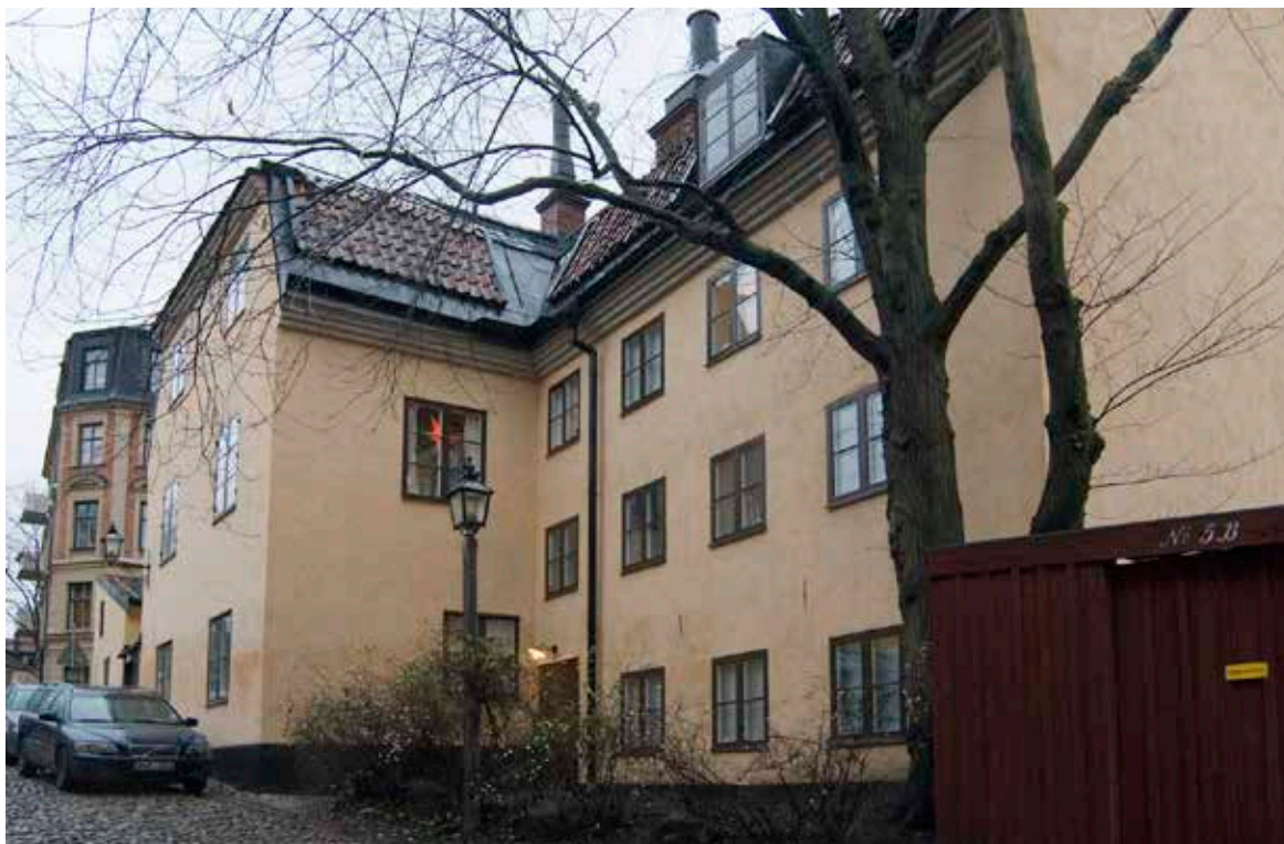
STENHUSET VID RODDARGATAN 5 NÄRMAST OCH BAKOM DET SYNS GAVELN TILL RODDARGATAN 3. FOTO J. MALMBERG.
