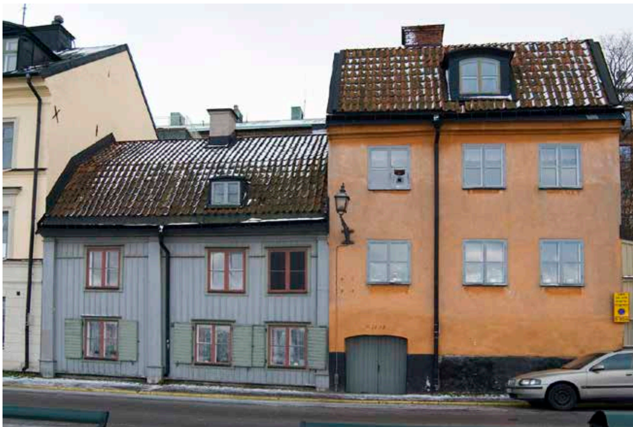
FJÄLLGATAN 38 MED TRÄHUSET FRÅN 1720-TALET OCH STENHUSET FRÅN 1750-TALET. FOTO J. MALMBERG.
