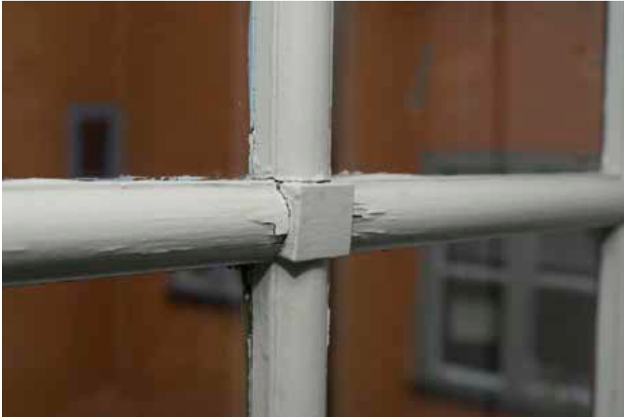
FÖNSTER MED TÄRNINGSSPRÖJS AV 1700-TALSTYP. FOTO J. MALMBERG.
