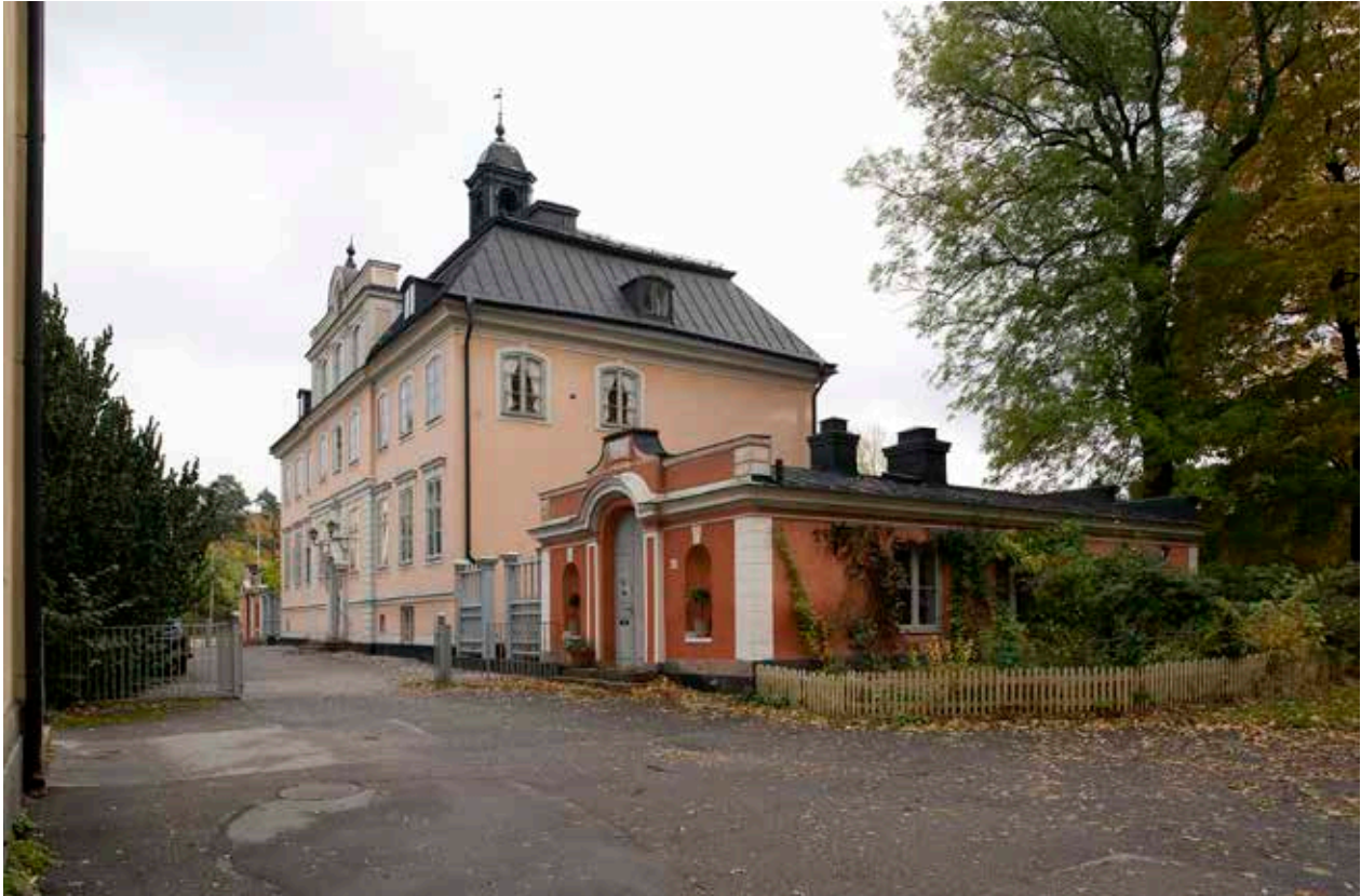
HUVUDBYGGNADEN MED DEN VÄSTRA PAVILJONGEN. MELLAN PAVILJONGERNA OCH HUVUDBYGGNADENS GAVLAR ÄR HÖGA TRÄSTAKET, UTFÖRDA EFTER ORIGINAL FRÅN 1800-TALET S MITT. FOTO I. JOHANSSON, SSM.
