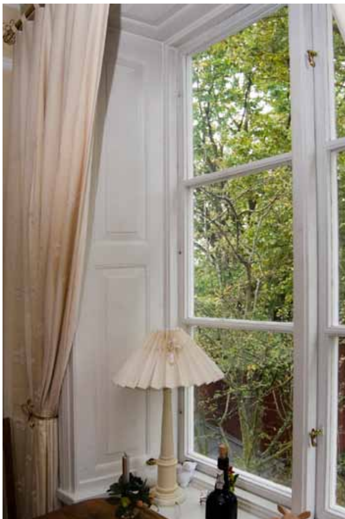
HALVFRANSKA, PROFILERADE FÖNSTERSMYGPANELER. FOTO: J. MALMBERG.
