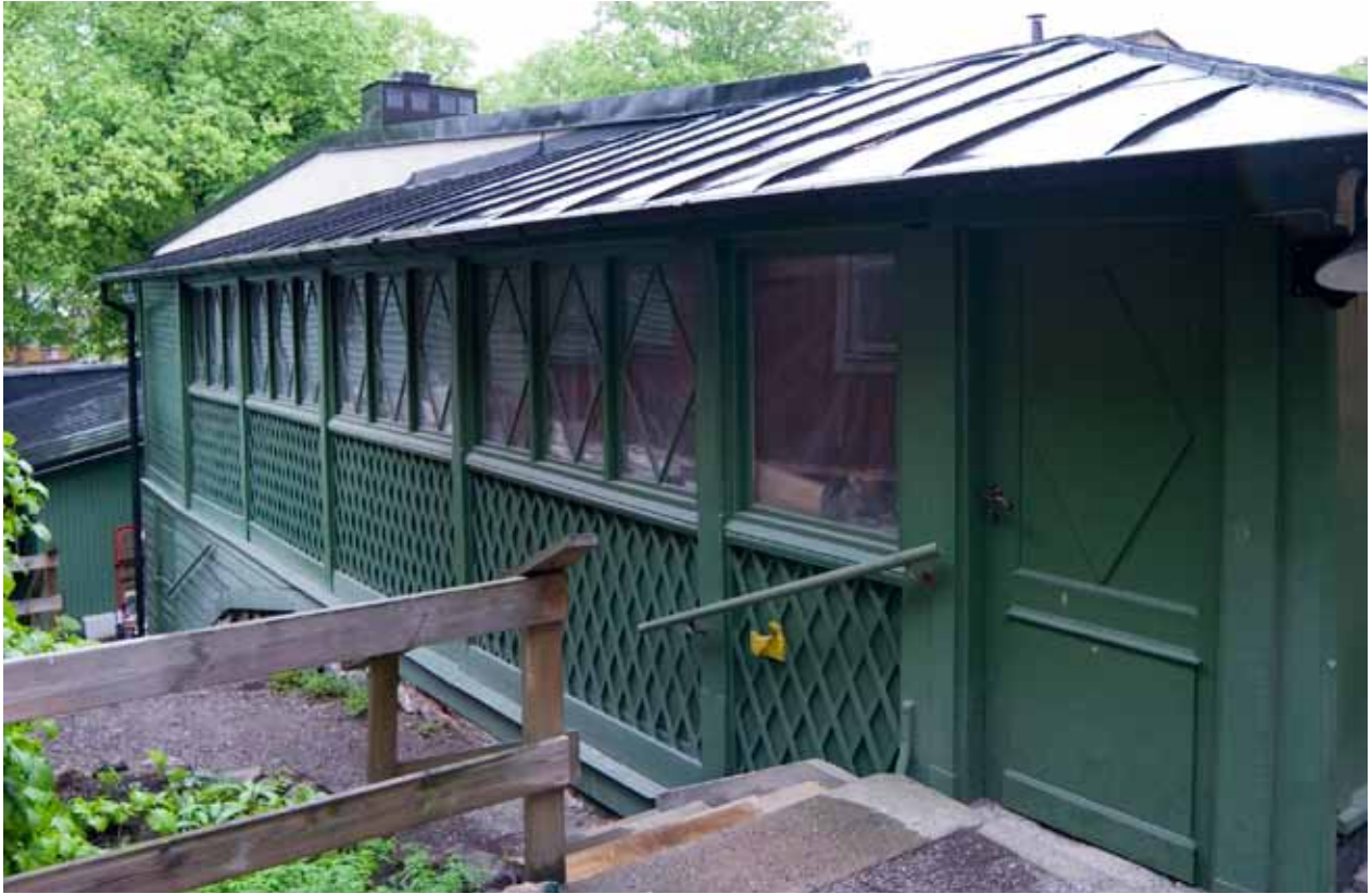
DEN GRÖNA SERVERINGSVERANDAN HAR FÖNSTER MED SPRÖJS I ROMBMÖNSTER. FOTO: J. MALMBERG.
