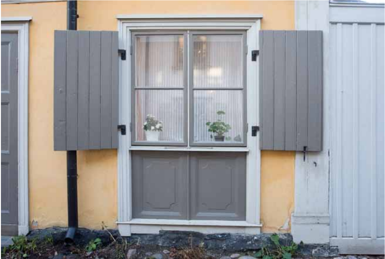
FÖNSTER MOT BREDA GATAN MED LUCKOR OCH DEKORATIVT RAMVERK UNDER. FOTO: J. MALMBERG.
