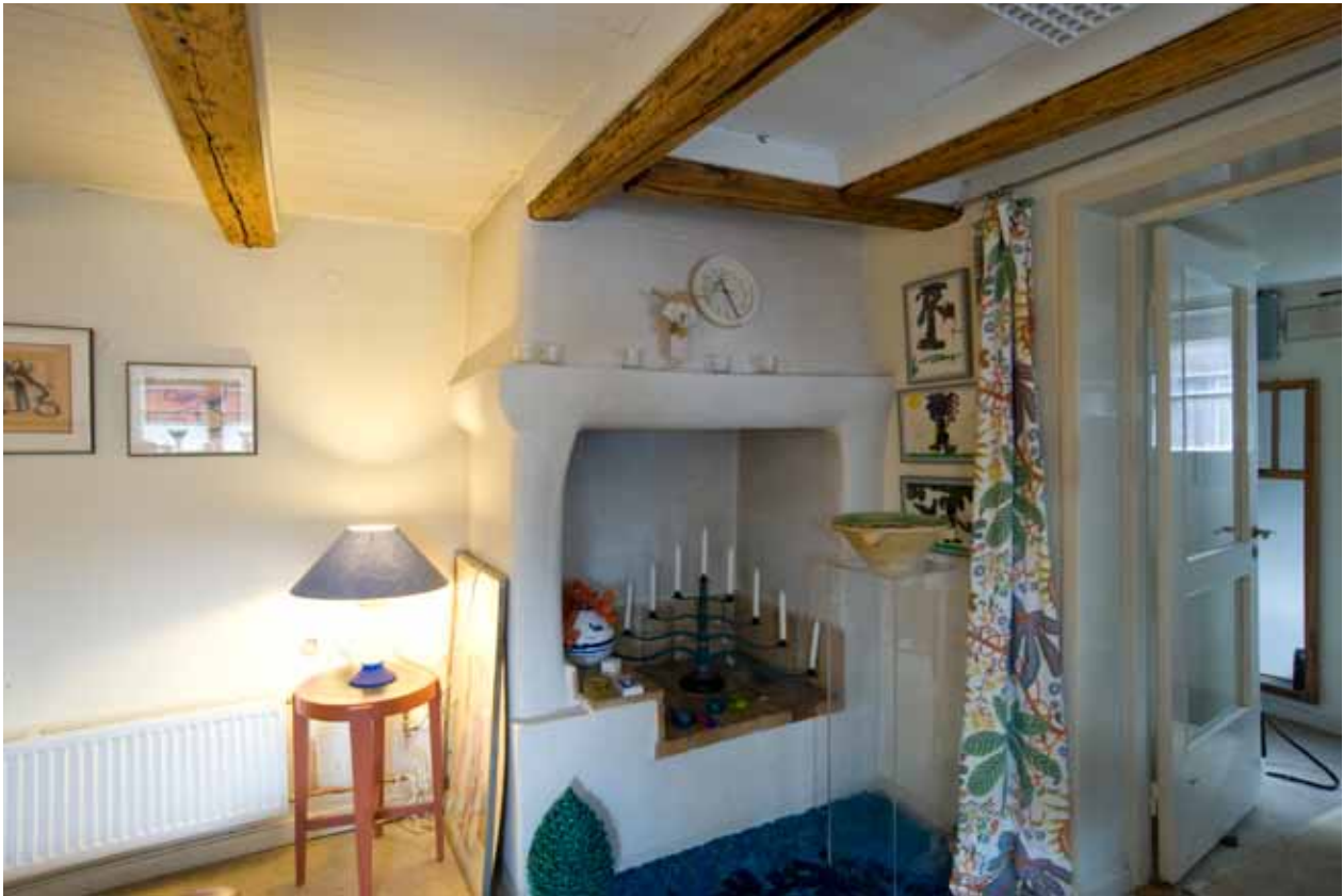
TAKBJÄLKAR OCH ÄLDRE MURAD SPIS I DEN VÄSTRA STUGAN. FOTO: J. MALMBERG.
