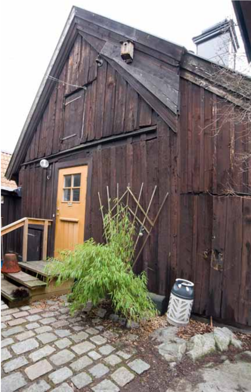
DEN VÄSTRA STUGAN MED DELAR AV DEN ÄLDRE PANELN BEVARAD. TILL HÖGER SYNS UTBYGGNADEN SOM INNEHÖLL EN ÄLDRE TVÄTTSTUGA MED BEVARAD MURAD SPIS. FOTO: J. MALMBERG.
