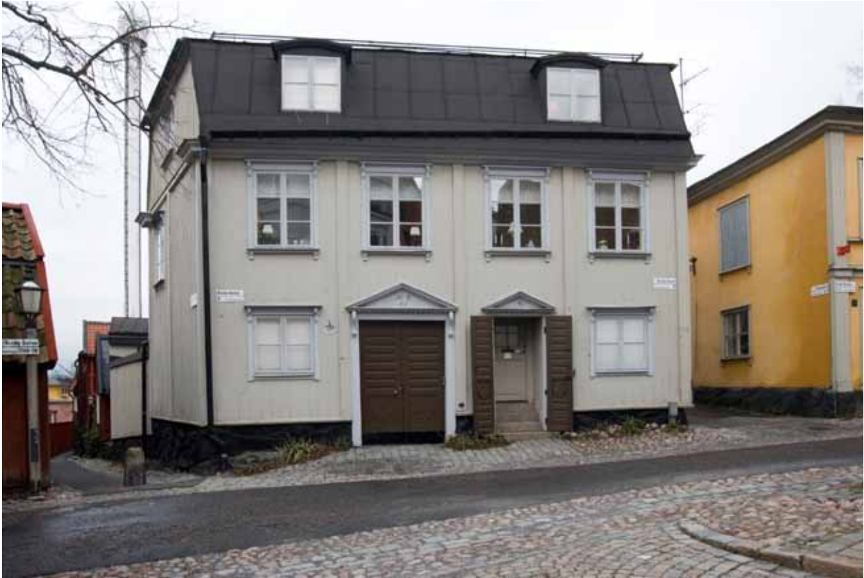
HUVUDFASAD MOT GATAN, PRÄGLAT AV 1800-TALET'S FORMSPRÅK MED LJUSA FASADER I TVÅ VÅNINGAR. FOTO: J MALMBERG.
