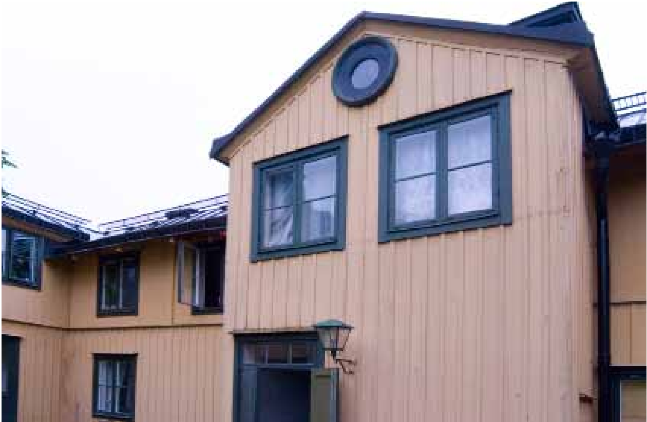
TRAPPHUSET LIGGER I DET BETONADE MITTPARTIET MOT GÅRDEN. FOTO: J. MALMBERG.
