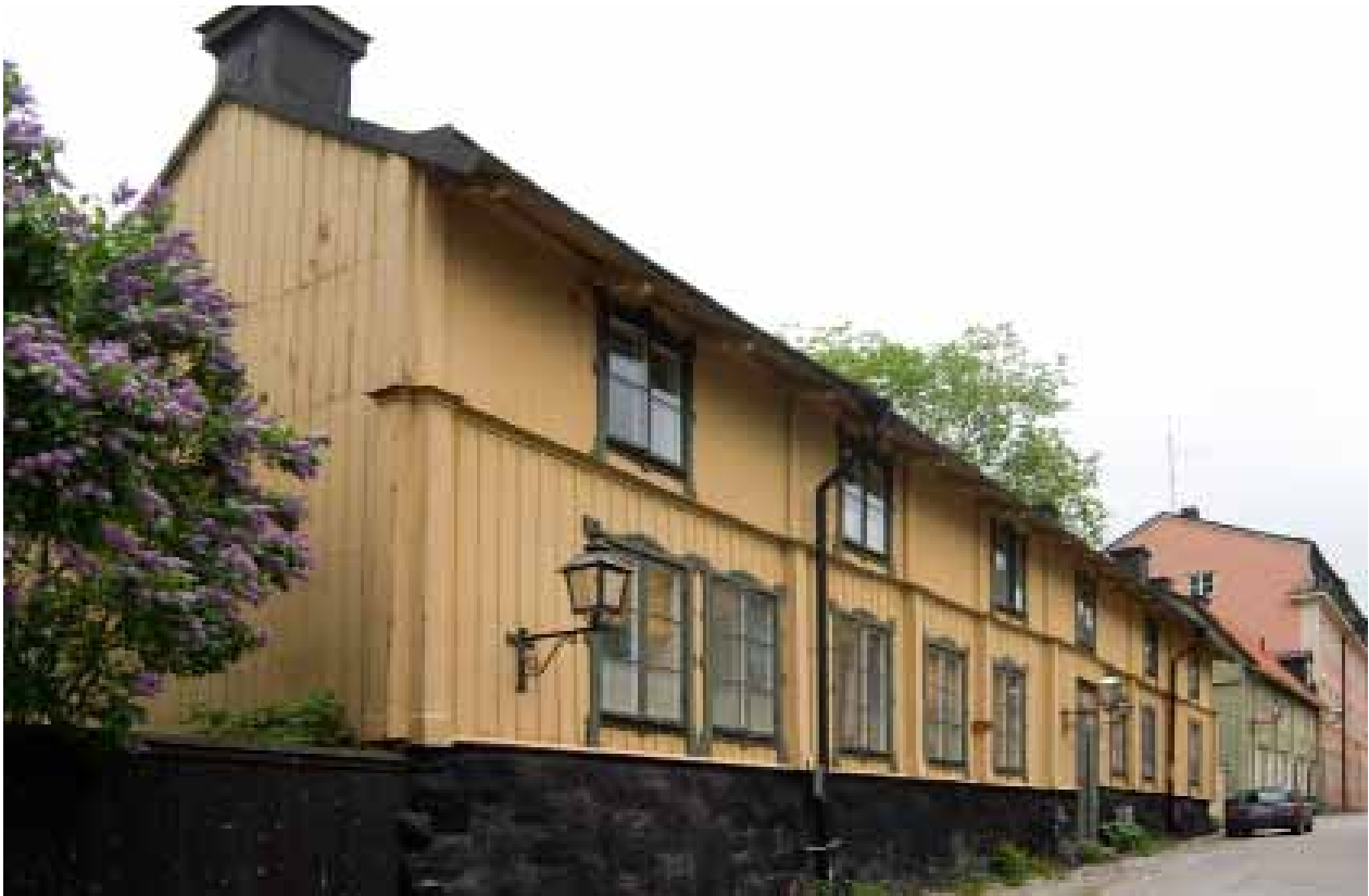
GATHUSET HAR LÖVSÅGADE FÖNSTERFODER OCH KNUTLÅDOR UTFORMADE SOM PILASTRAR. FOTO: J. MALMBERG.
