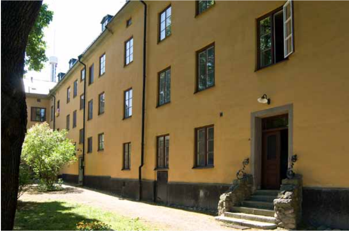
GÅRDSFASADEN TILL BEBYGGELSEN MOT FALKENBERGSGATAN. HUS 1 I FÖRGRUNDEN HAR EN TRAPPA MED SIDOR AV MARKSTEN SAMT DEKORATIVT SMIDESRÄCKE. HUS 2 OCH 3 HAR OLIKA BJÄLKLAGSHÖJDEN VILKET SYNS I FÖNSTRENS HÖJD. FOTO: J. MALMBERG.
