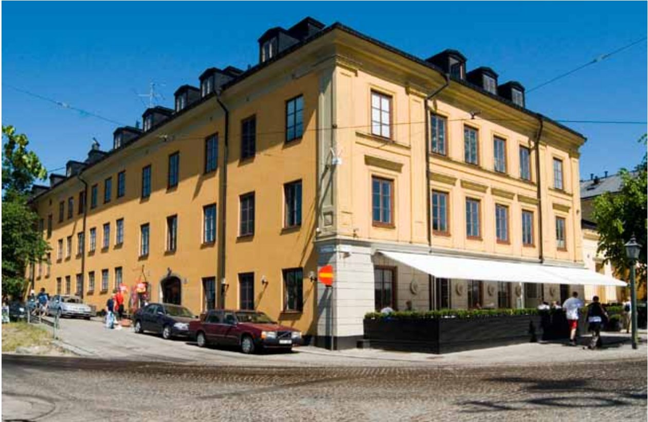
BYGGNADEN SEDD FRÅN HÖRNET ALLMÄNNA GRÄND /FALKENBERGSGATAN. I FASADEN MOT FALKENBERGSGATAN KAN DE OLIKA BYGGNADSETAPPERNA AVLÄSAS I DE SKILJDA FÖNSTERHÖJDerna. FOTO: J. MALMBERG.
