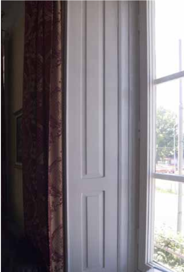
PROFILERAD FÖNSTERSMYGPANEL FRÅN 1800-TALET'S ANDRA HÄLFT. FOTO: J. MALMBERG.
