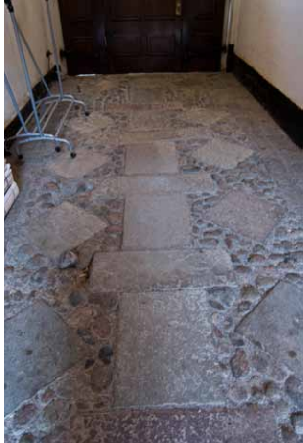
PORTGÅNGEN FRÅN FALKENBERGSGATAN TILL GÅRDEN HAR MARKBELÄGGNING AV MÖNSTERLAGD STEN. FOTO: J. MALMBERG.
