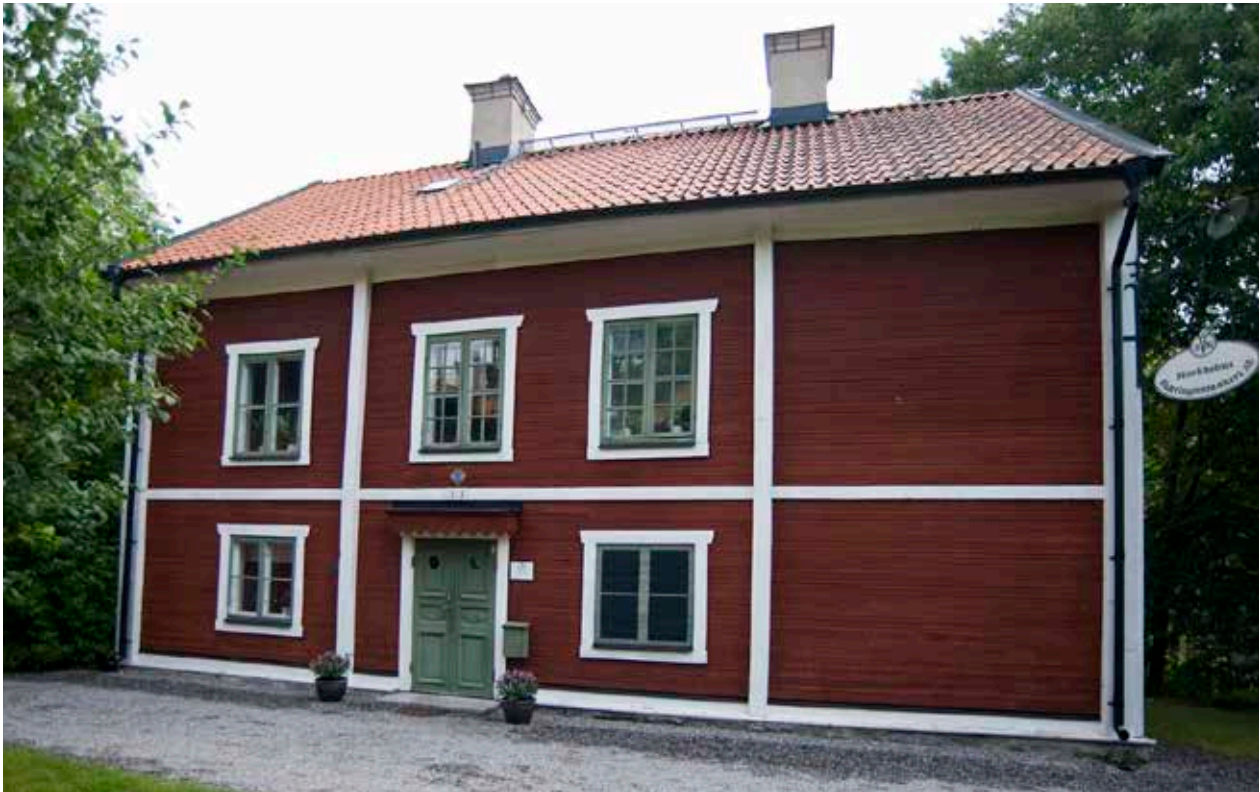
STORA KNAPERSTA SETT FRÅN GÅRDSPLANEN. ENTRÉN HAR EN HELFRANSK PARDÖRR FRÅN 1800-TALET. FOTO: J. MALMBERG.
