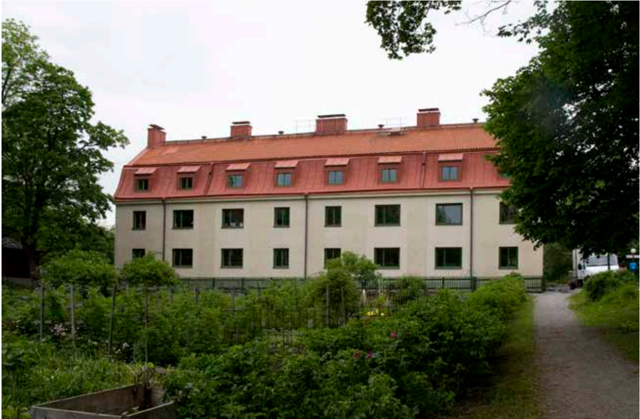
FASADEN MOT SÖDER. FOTO: J. MALMBERG.
