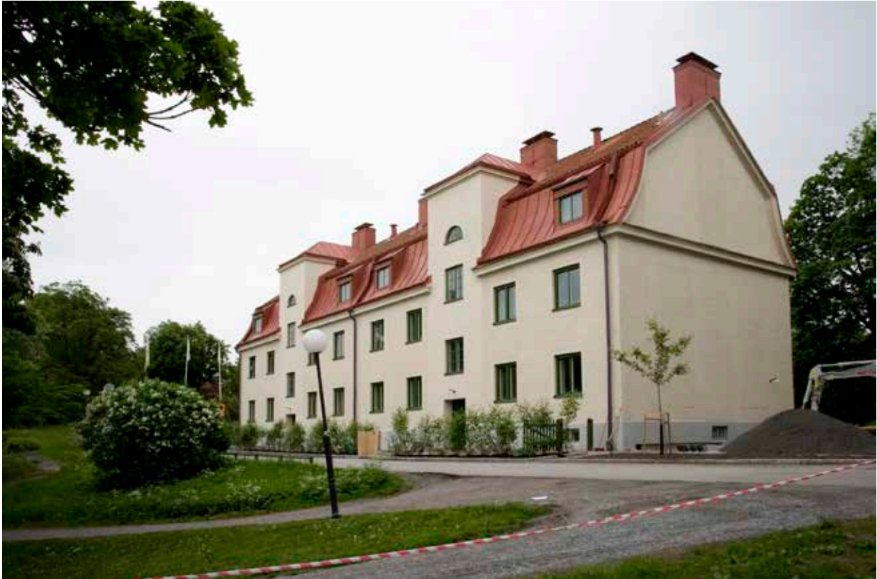
FASADEN MED VY FRÅN NORDVÄST. HÄR SYNS HUSETS TRAPPLOPPSUPPBYGGNADER SAMT DE SVÄNGDA GAVELPARTIERNA. FOTO: J. MALMBERG.
