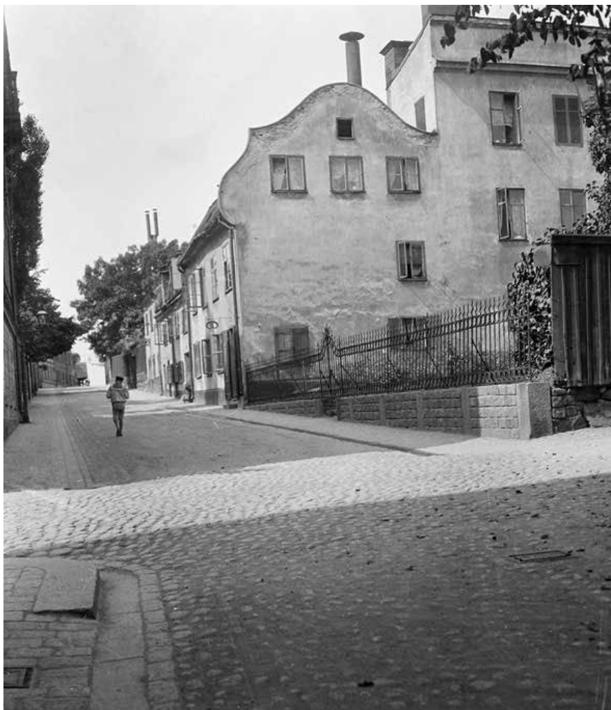
KATTÖRAT 1 OMKRING SEKELSKIFTET 1900. DET NUVARANDE GATHUSET HAR KVAR SIN ÖPPNING MOT GATAN MED EN KRINGLA OVAN DÖRREN. VÄSTER OM HUSET STÅR DET ÄLDRE GATHUSET, IDAG RIVET. NÄRMST I BILD SYNS TRÄDGÅRDEN MED ETT DEKORATIVT JÄRNSTAKET. FOTO: K. SALIN. SSMF003542.
