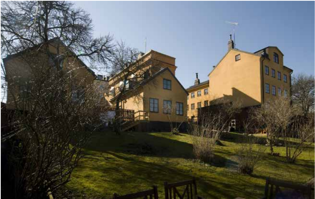
FASTIGHETEN KATTÖRAT 1 MED TRÄDGÅRD MOT NORR. FOTO J. MALMBERG.
