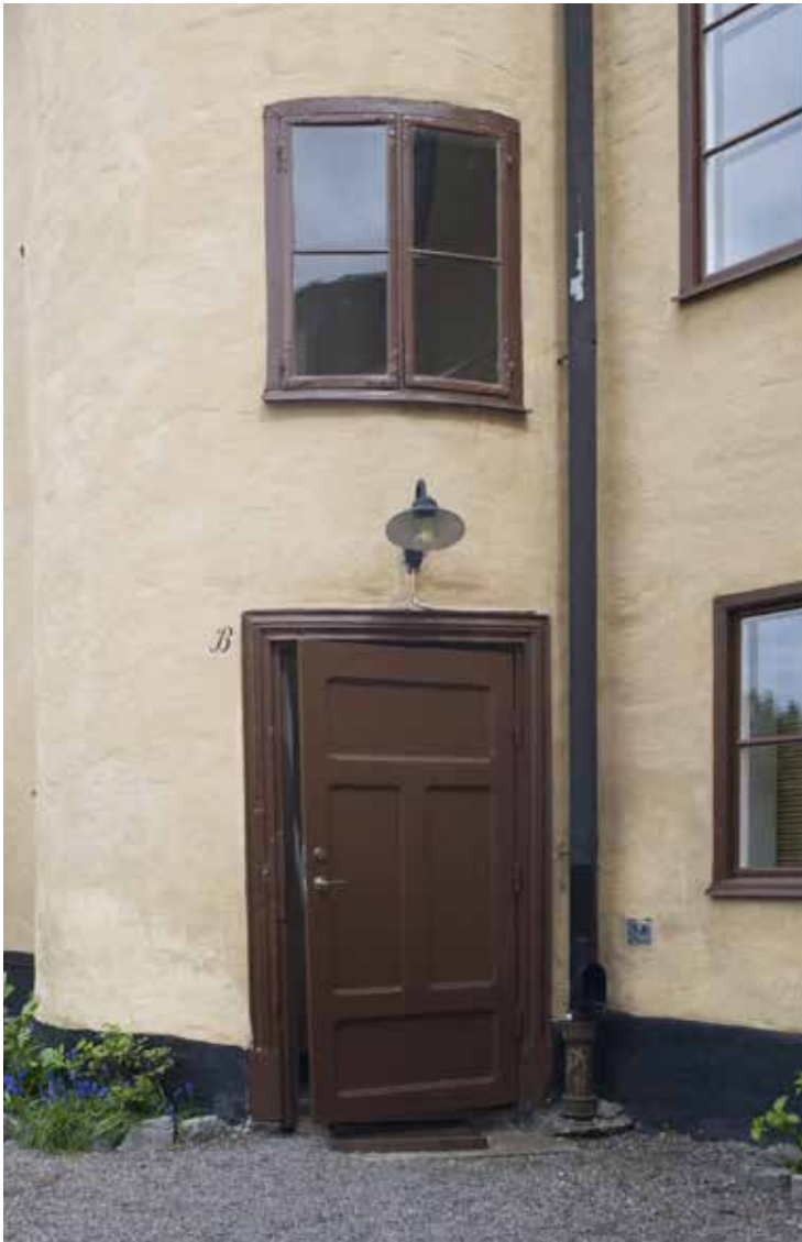
GÅRDSFLYGELNS VÄLVDVA TRAPPHUS MED URSPRUNGLIGA FÖNSTER. FOTO: J. MALMBERG.
