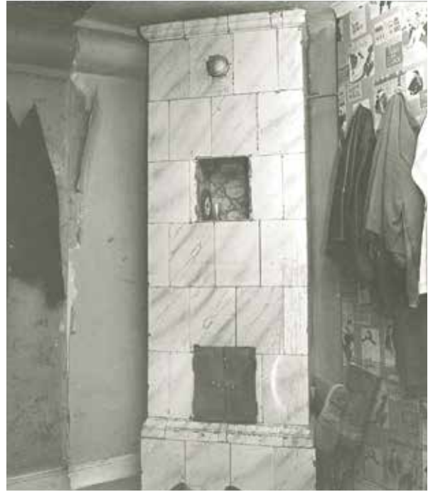
KAKELUGN I GATHUSETS BOTTENVÅNING, NUMER RIVEN. FOTO: LARS JOHANSSON 1968. SSMF83280.
