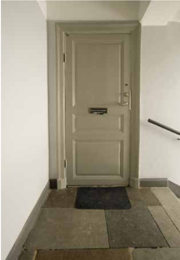
TRAPPHUS PÅ BASTUGATAN 44B MED Fyllningsdörrar och kalkstensgolv. FOTO: J. MALMBERG.
