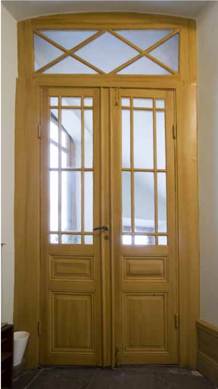
URSPRUNGLIG PARDÖRR I TRAPPHUSET MED SPRÖJSADE GLAS OCH ÖVERLJUSFÖNSTER SAMT DEL AV DEN URSPRUNGLIGA FOTPANELEN FOTO. J MALMBERG.
