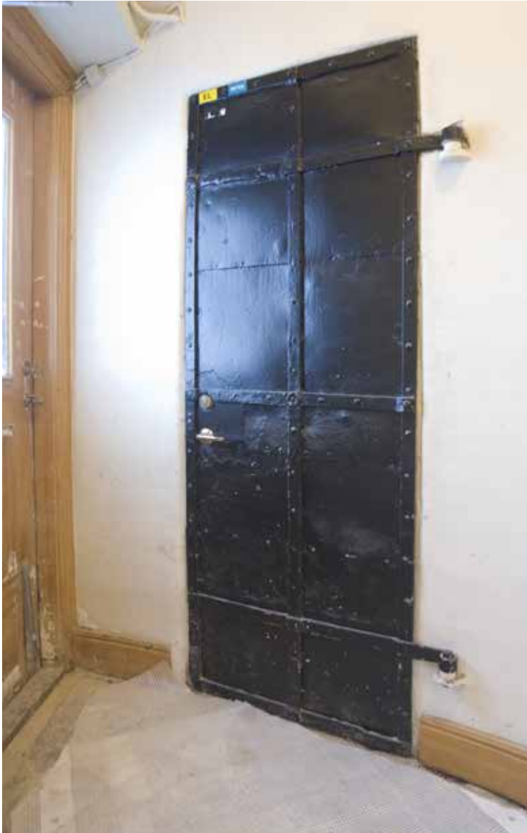
ÄLDRE JÄRNDÖRR TILL KÄLLAREN. FOTO. J MALMBERG.
