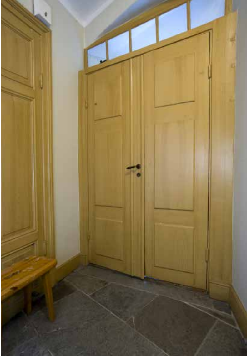
PARDÖRR I TRAPPHUSET MED ÖVERLJUSFÖNSTER OCH KALKSTENSGOLV. FOTO. J MALMBERG.
