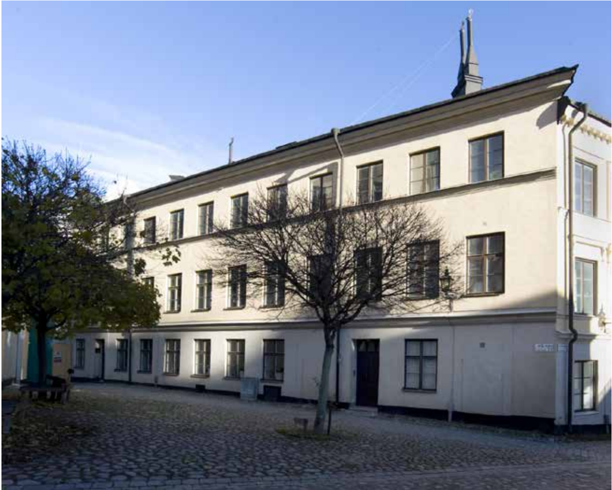
BOSTADSHUSET MED FASADER I SLÄTPUTS OCH PROFILERADE FRISER. FOTO. J MALMBERG
