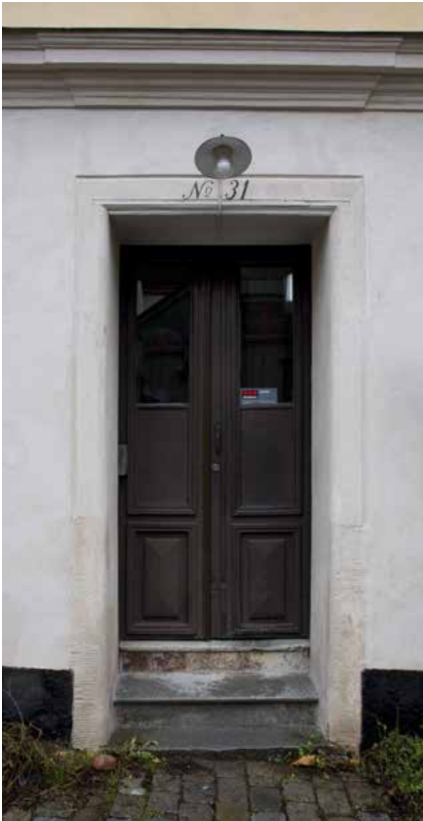
HUVUDENTRÉ MED URSPRUNGLIG PARDÖRR BEVARAD, DOCK NÅGOT FÖRÄNDRAD MED ETT IGENSATT FÖNSTERPARTI. FOTO: J. MALMBERG.
