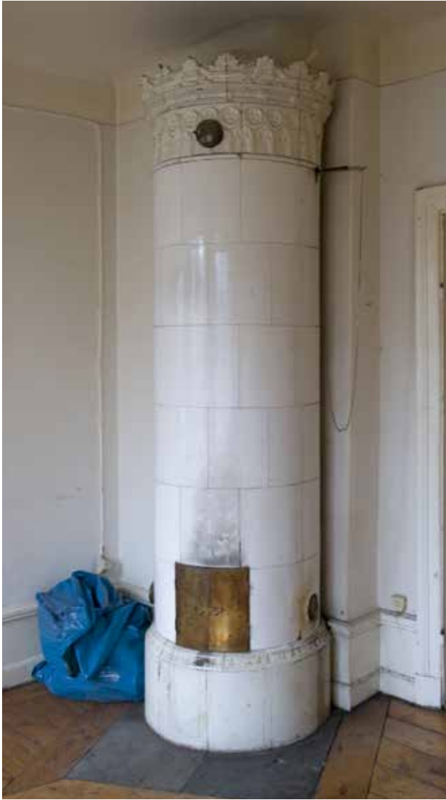
I LÄGENHETERNA FINNS BEVARADE BRÄDGOLV, FOTPANELER OCH RUNDA KAKELUGNAR. FOTO: J. MALMBERG.
