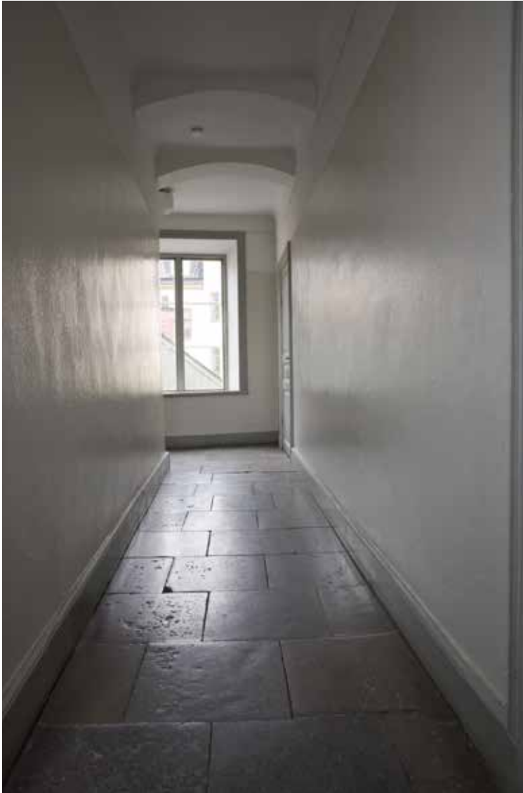
TRAPPHUSET ÄR VÄLBEVARAT MED URSPRUNGLIGT KALKSTENSGOLV, SOCKLAR, Fyllningsdörrar och FODER. FOTO: J. MALMBERG.
