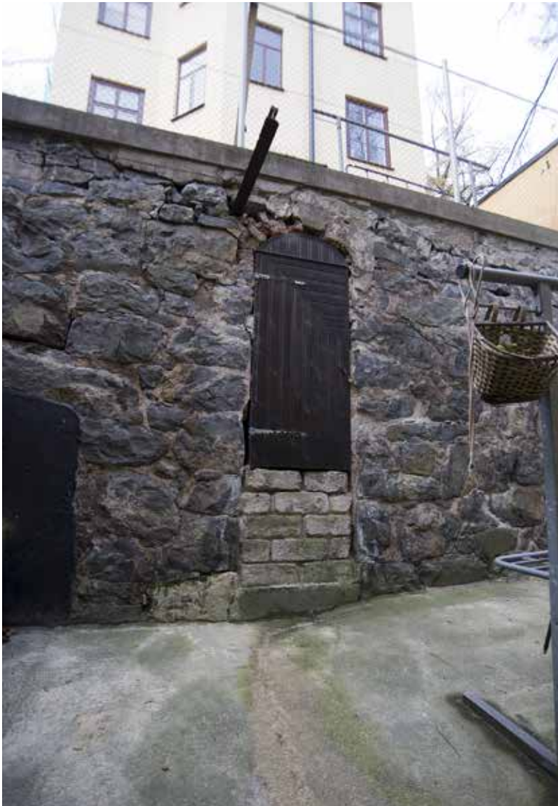
AVSKILJANDE MUR MELLAN GÅRDARNA MED ÄLDRE DÖRR KLÄDD MED PÄRLSPONTSPANEL. UNDER DÖRREN FINNS SPÅR AV TRAPPA. FOTO: J MALMBERG
