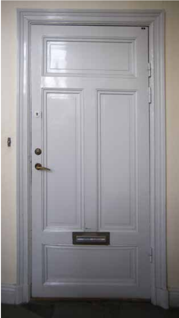
URSPRUNGLIG LÄGENHETSDÖRR MED FYRA FYLLNINGAR OCH SAMTIDA PROFILERADE DÖRRFODER. FOTO: J MALMBERG
