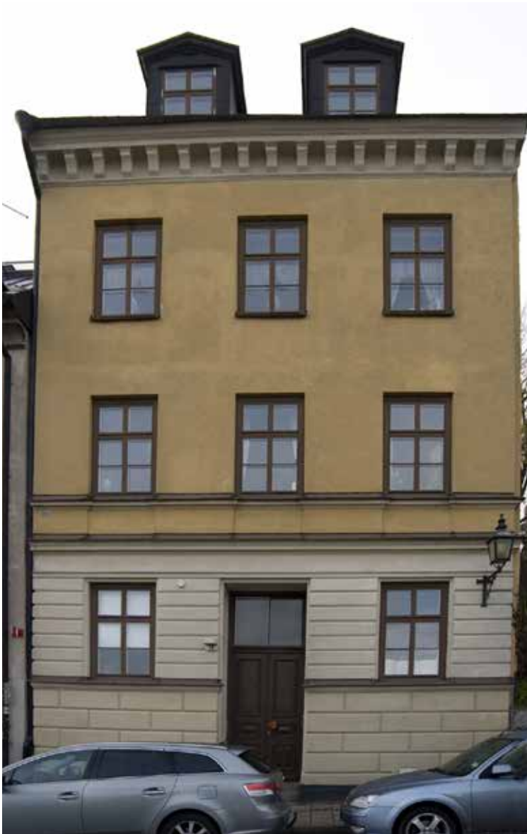
HUVUDFASADEN MOT GATAN MED RUSTICERAD BOTTENVÅNING. FASADEN VAR URSPRUNGLIGEN RIKT DEKORERAD MEN HAR SENARE SKALATS AV. FOTO: J MALMBERG
