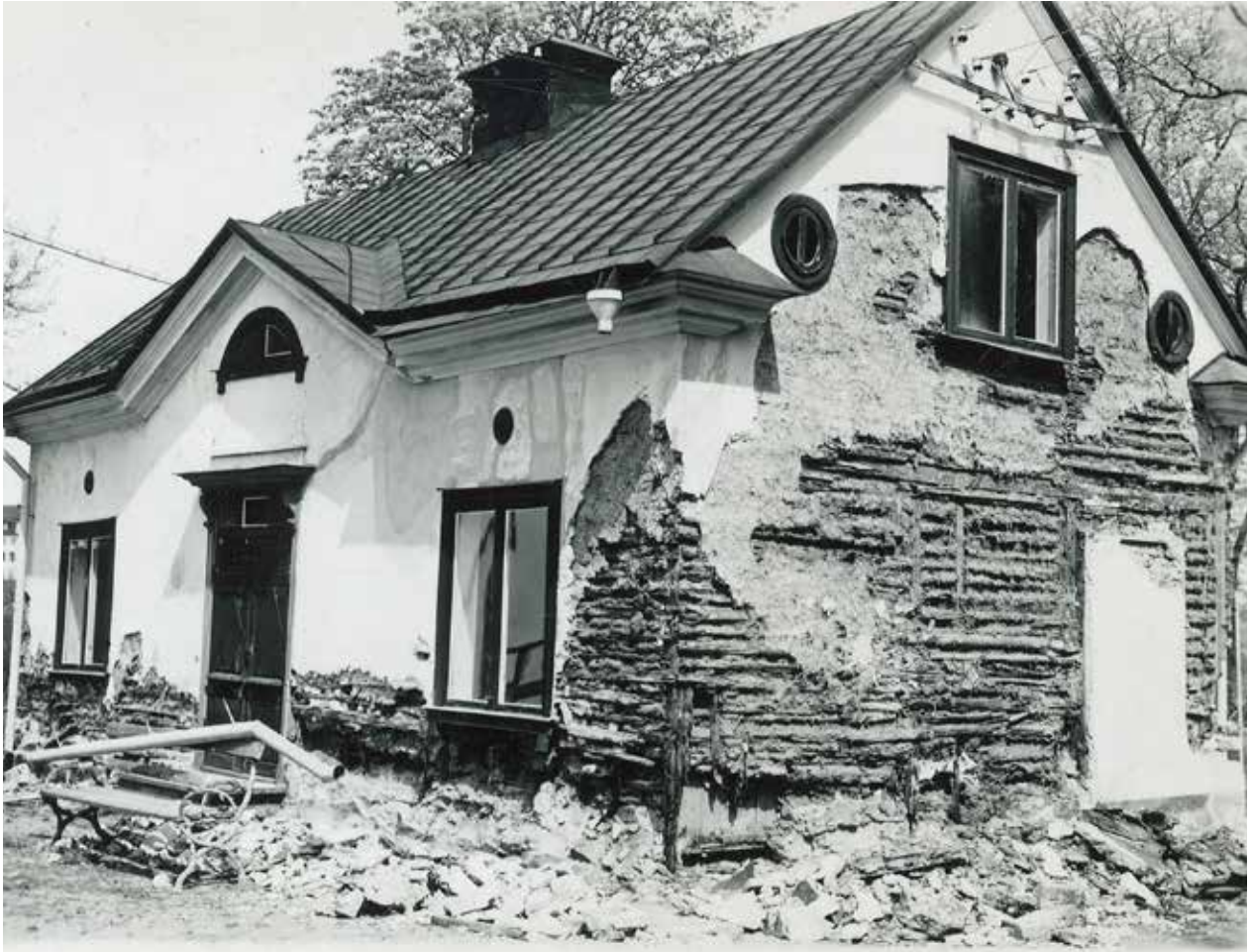
ÖSTRA FLYGELN MED DELVIS SYNLIG KALKBRUKSSTOMME VID UPPRUSTNINGEN I BÖRJAN AV 1950-TALET. FOTO F. LARCKE, SSM F55017.
