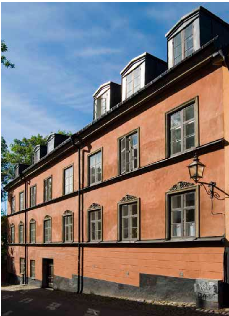
FASADEN MOT GATAN MED SLÄTPUTS OCH ORNAMENT OVANFÖR FÖNSTREN. FOTO J. MALMBERG.
