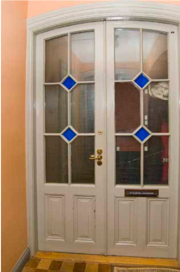
EN AV DE DÖRRAR SOM TIDIGARE LEDDE TILL KORRIDORERNA FRÅN TRAPPHUSET. FOTO J. MALMBERG.
